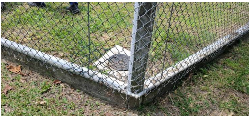
Foto 12: Falha na cerca reparada (foto enviada pela Concessionária).
