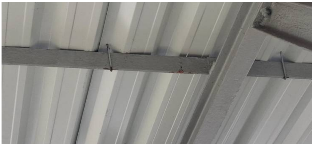
Foto 11: Cobertura da estação após remoção do ninho de marimbondo (foto enviada pela Concessionária).
