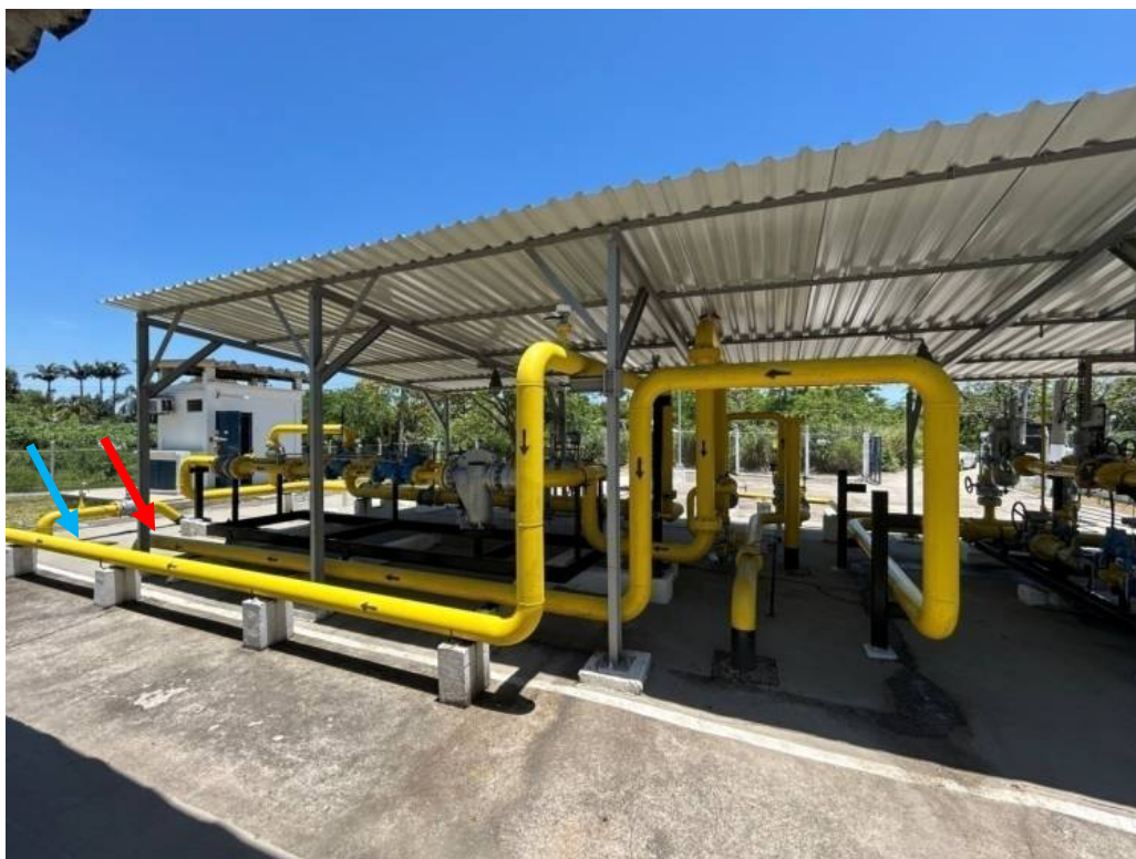
Foto 7: Linhas de saída da estação - abastecimentos de Itaguaí (seta vermelha) e da FCC (seta azul).
