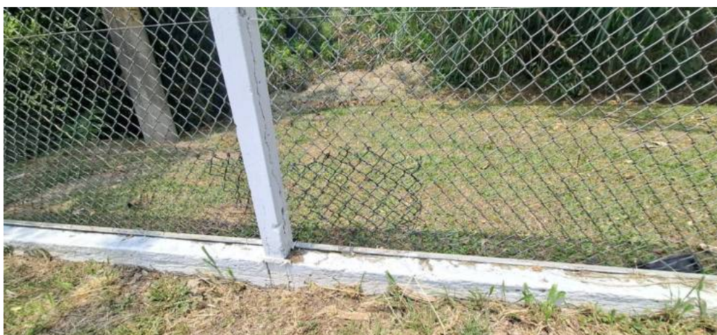
Foto 13: Falha na cerca reparada (foto enviada pela Concessionária).
