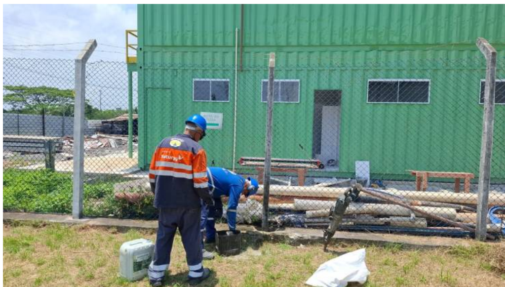
Foto 11: Funcionários da Concessionária reparando suporte da cerca (foto enviada pela Concessionária);
