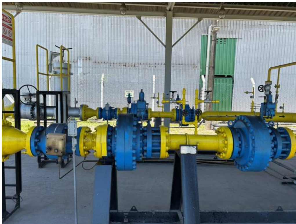
Foto 5: Reguladores nas duas linhas do sistema.
