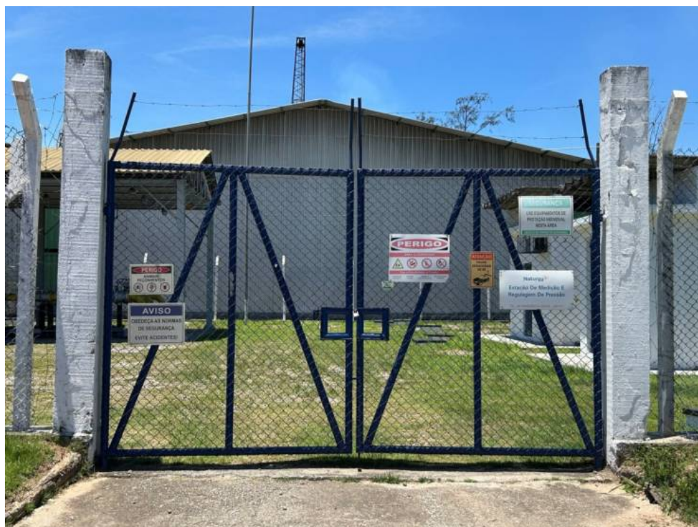
Foto 2: Entrada da ERM Furnas, com placas de sinalização de segurança.
