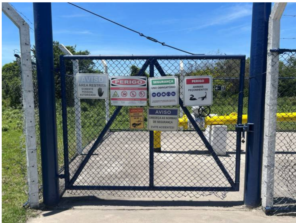
Foto 3: Portão de entrada com placas de sinalização de segurança.
