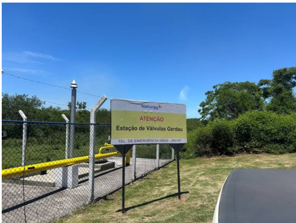
Foto 2: Placa de identificação da Estação de Válvulas Gerdau.
