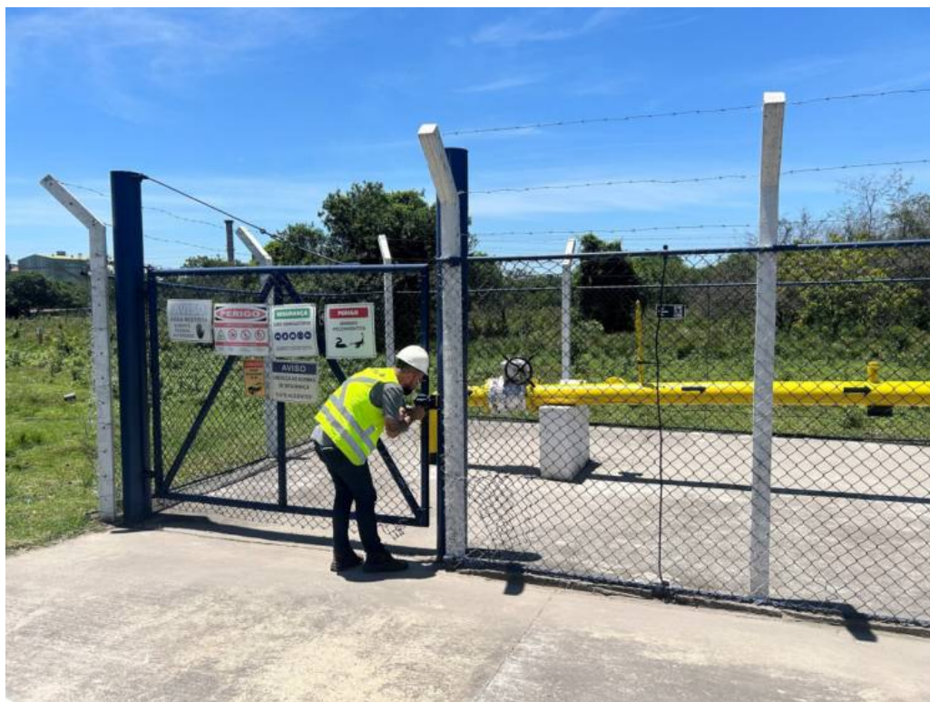
Foto 1: Entrada da estação de válvulas, com placas de sinalização de segurança.
