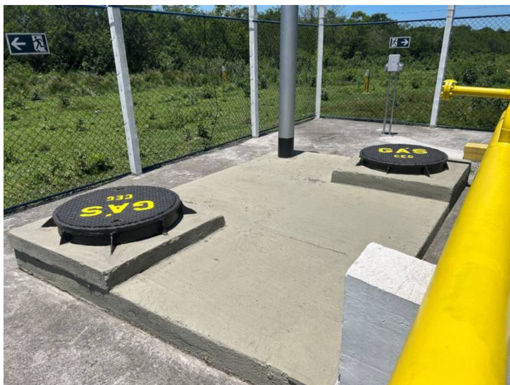
Foto 6: Acessos ao duto subterrâneo, que segue para a Estação Furnas.
