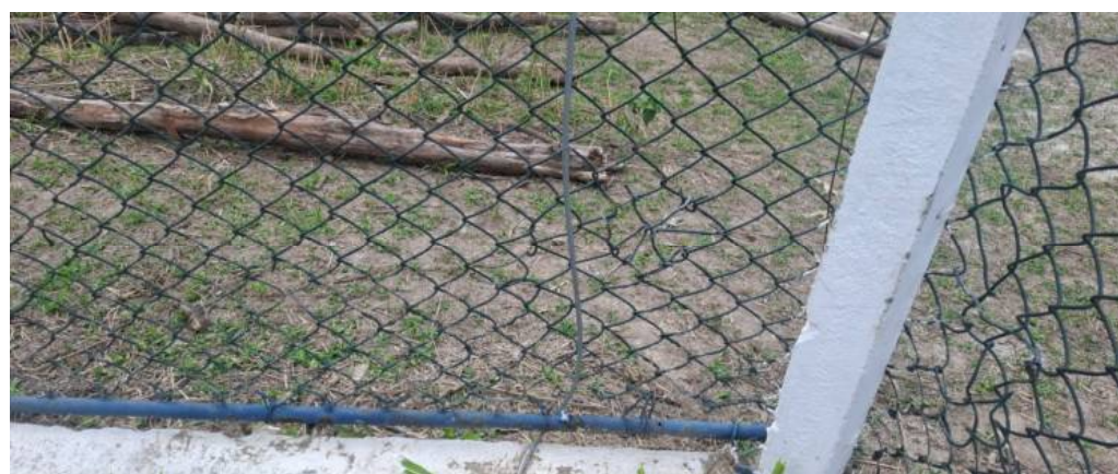
Foto 8: Falha na cerca reparada (foto enviada pela Concessionária).
