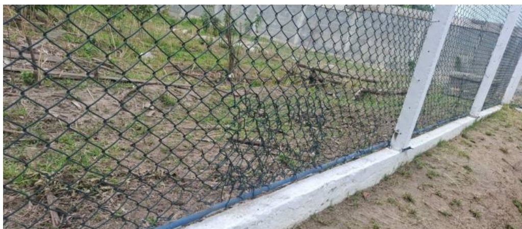
Foto 9: Falha na cerca reparada (foto enviada pela Concessionária).
