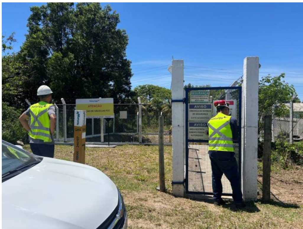
Foto 1: Entrada da estação de válvulas, com placas de identificação e de segurança.
