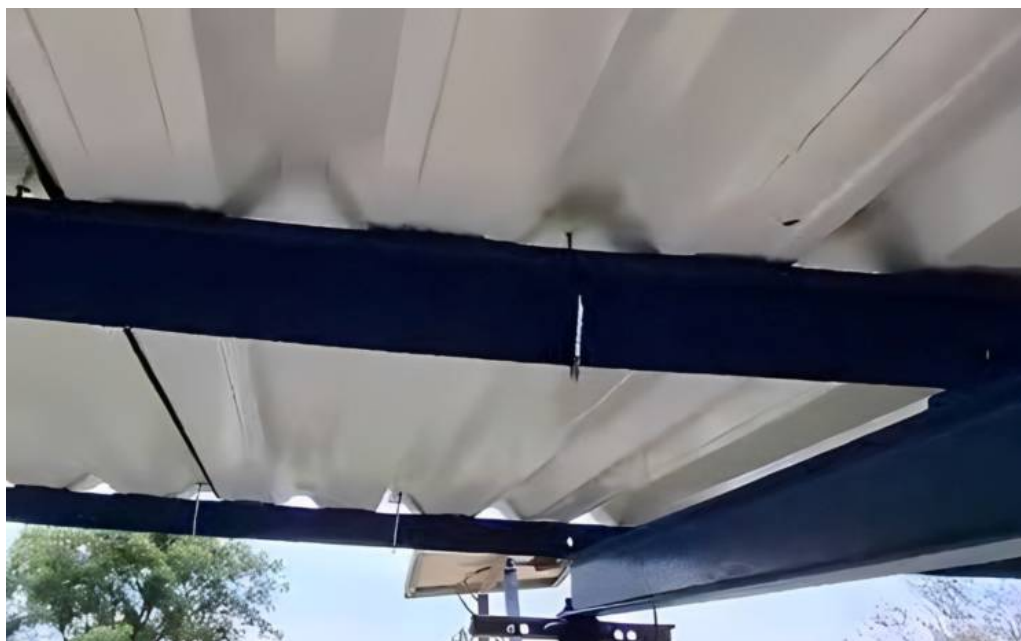
Foto 13: Cobertura da estação após remoção do ninho de marimbondo (foto enviada pela Concessionária).
