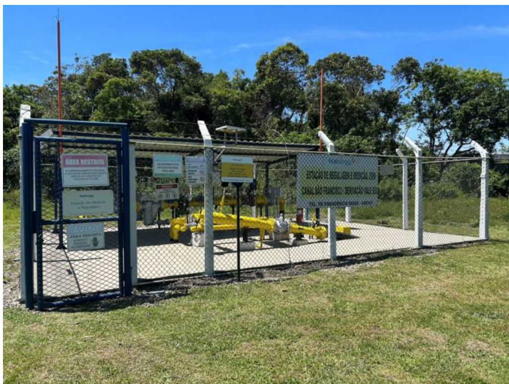
Foto 2: Vista externa da ERM São Francisco, com placas de identificação e de sinalização de segurança.
