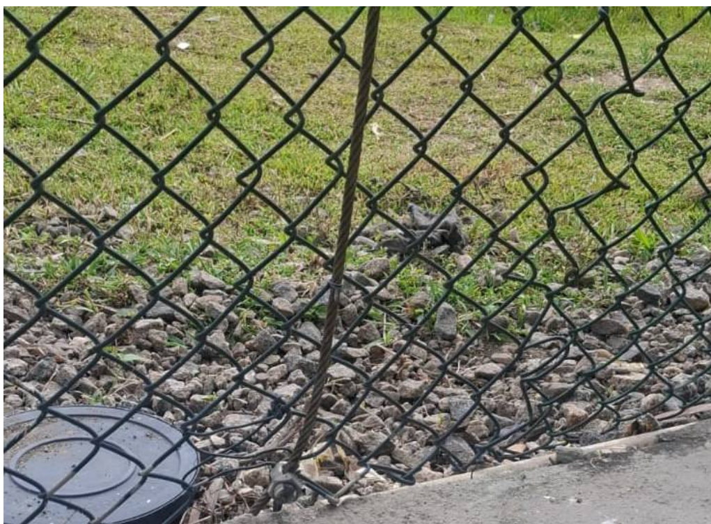
Foto 14: Falha na cerca reparada (foto enviada pela Concessionária).
