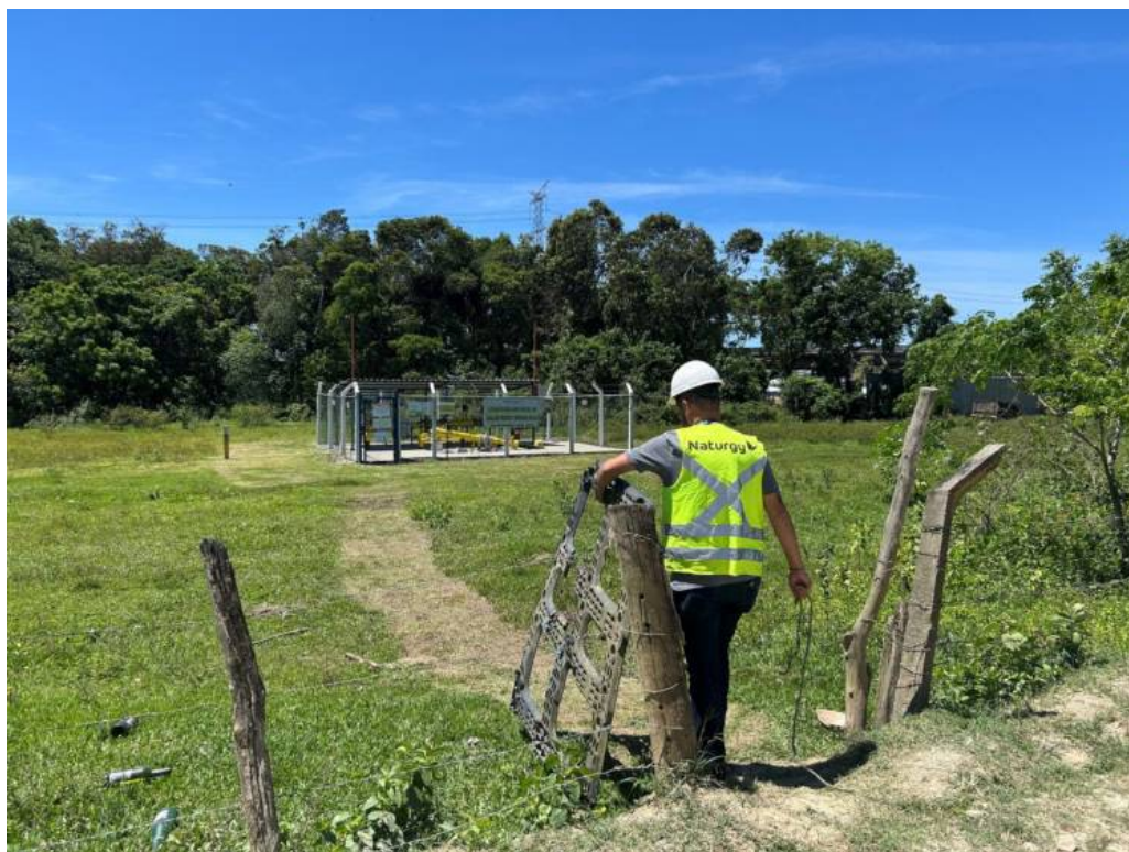
Foto 1: Entrada da área externa à ERM São Francisco.
