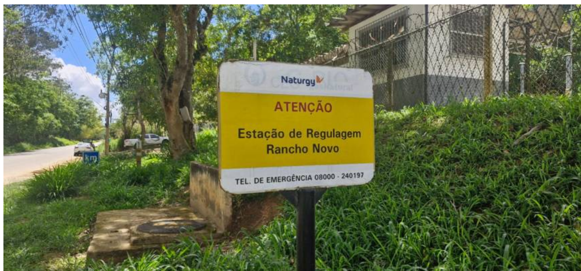
Foto 1: Placa de Identificação da Estação de Regulação subterrânea.
