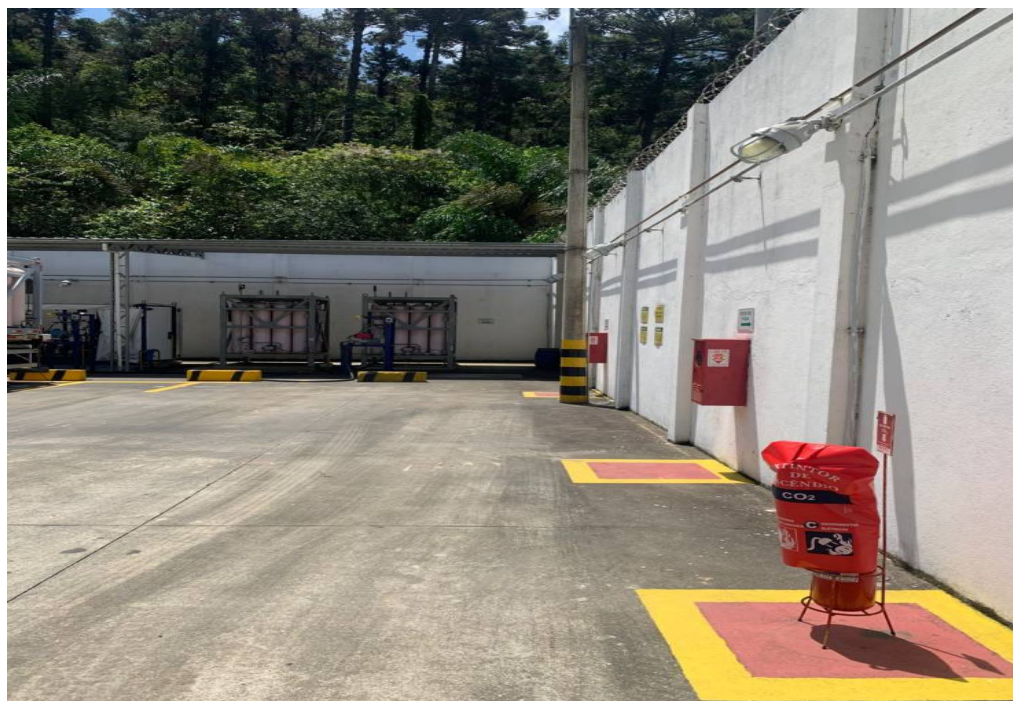
Foto 8: Área externa da estação com os extintores ao lado
