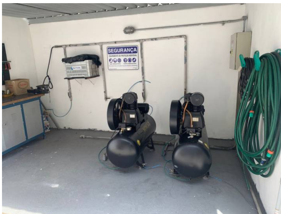
Foto 2: Sistema de acionamento pneumático
