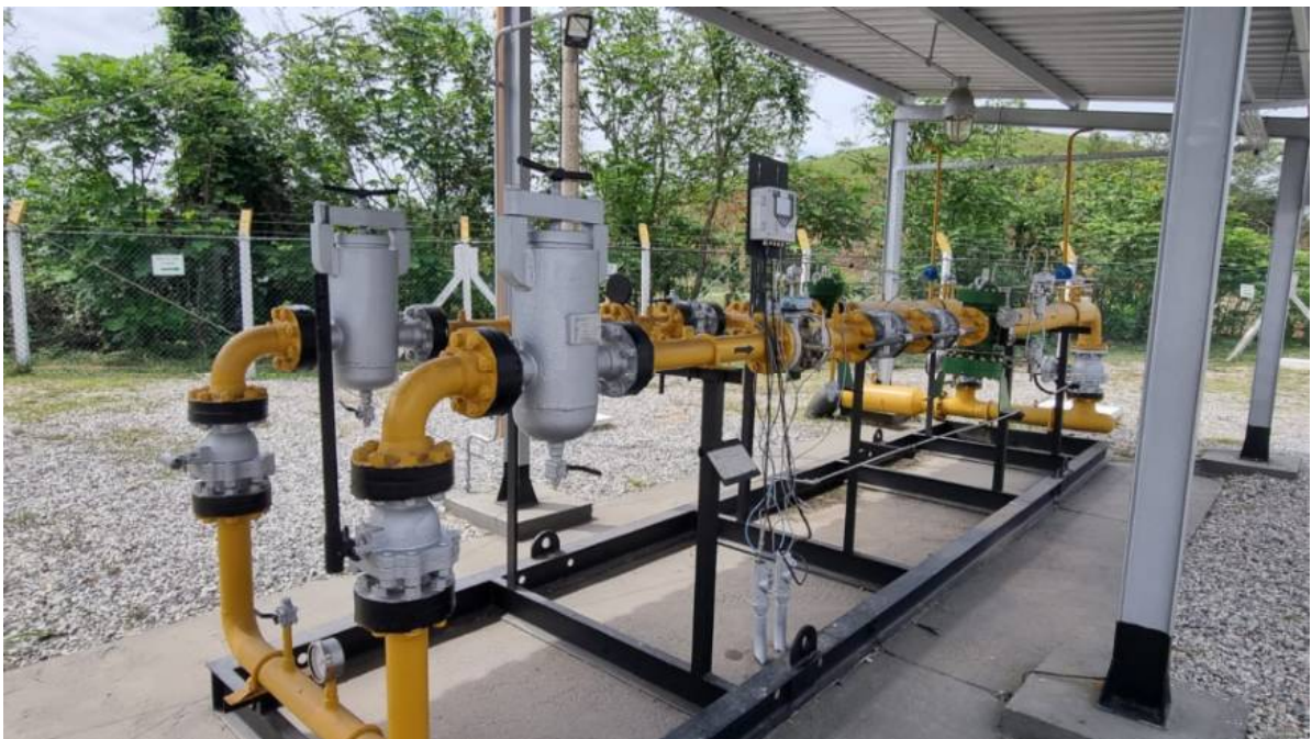
Foto 8: Módulo de regulação e medição composto por duas linhas paralelas.
