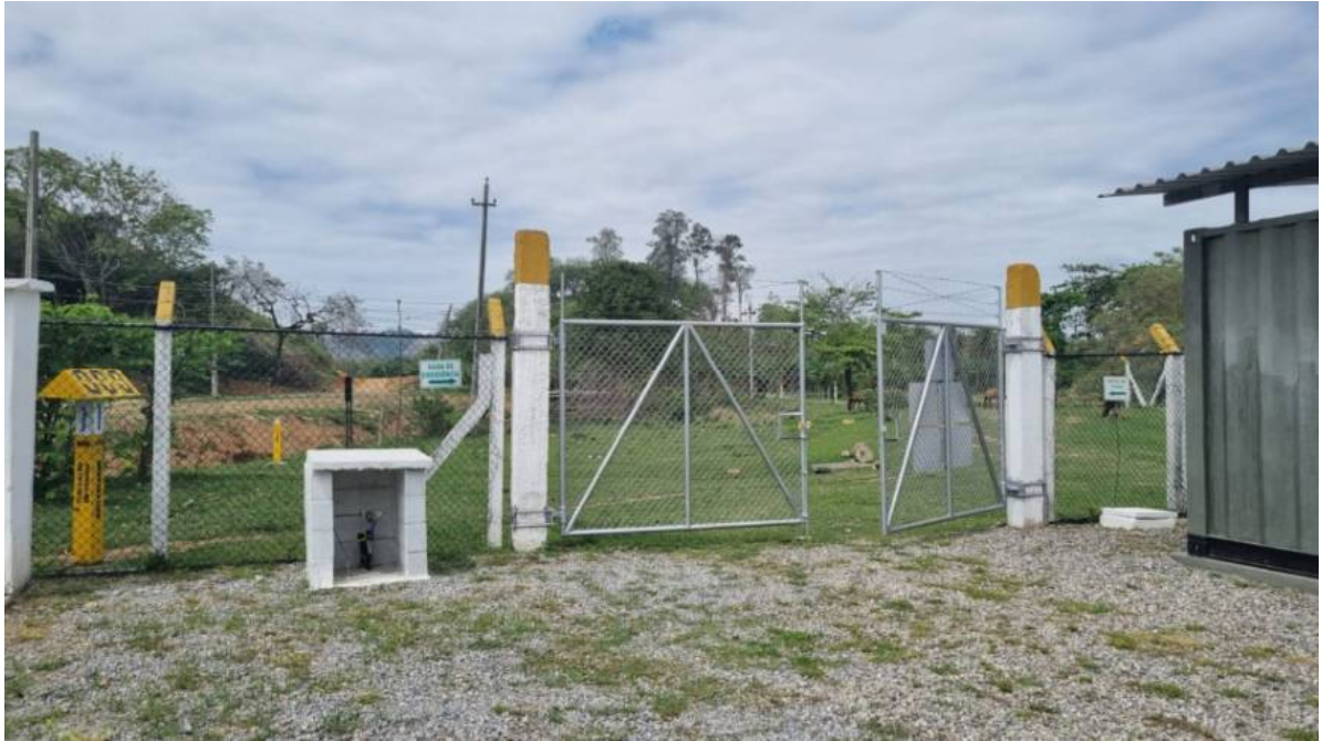
Foto 15: Sinalização de saída de emergência.
