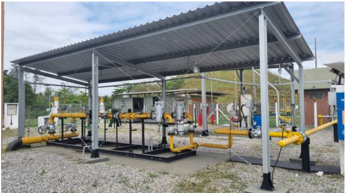
Foto 16: Vista lateral da estação.
