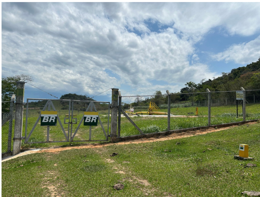
Foto 1: Portão de acesso à área de válvulas da Transpetro.
