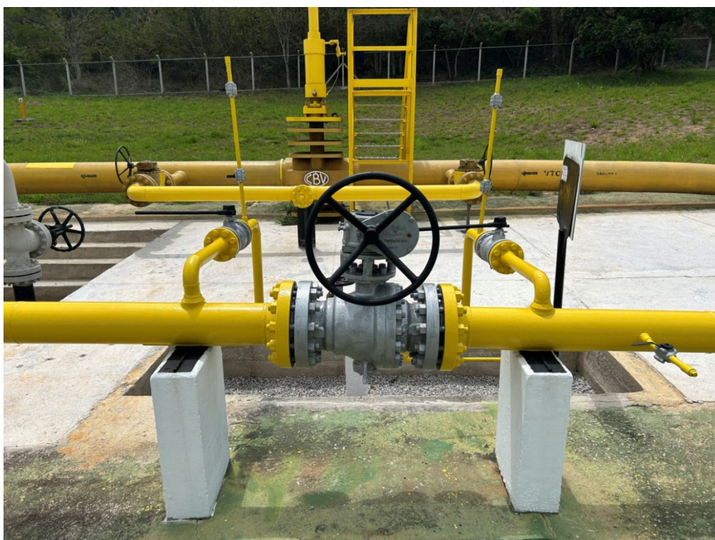
Foto 6: Válvula de bloqueio XV-110.
