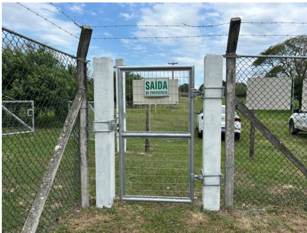
Foto 7: Placa de saída de emergência no portão.
