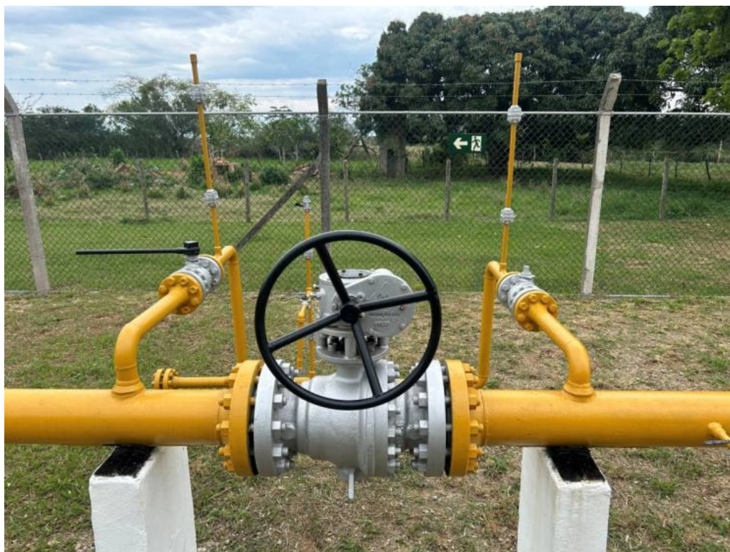
Foto 5: Válvula de bloqueio XV-120.
