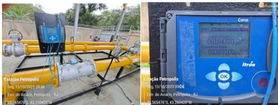
Foto 3: Medidor de vazão com conversor de volume.
