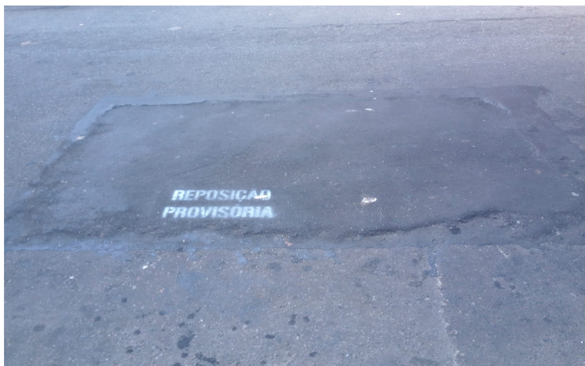
Foto 2: Recomposição provisória da via sinalizada com tinta
