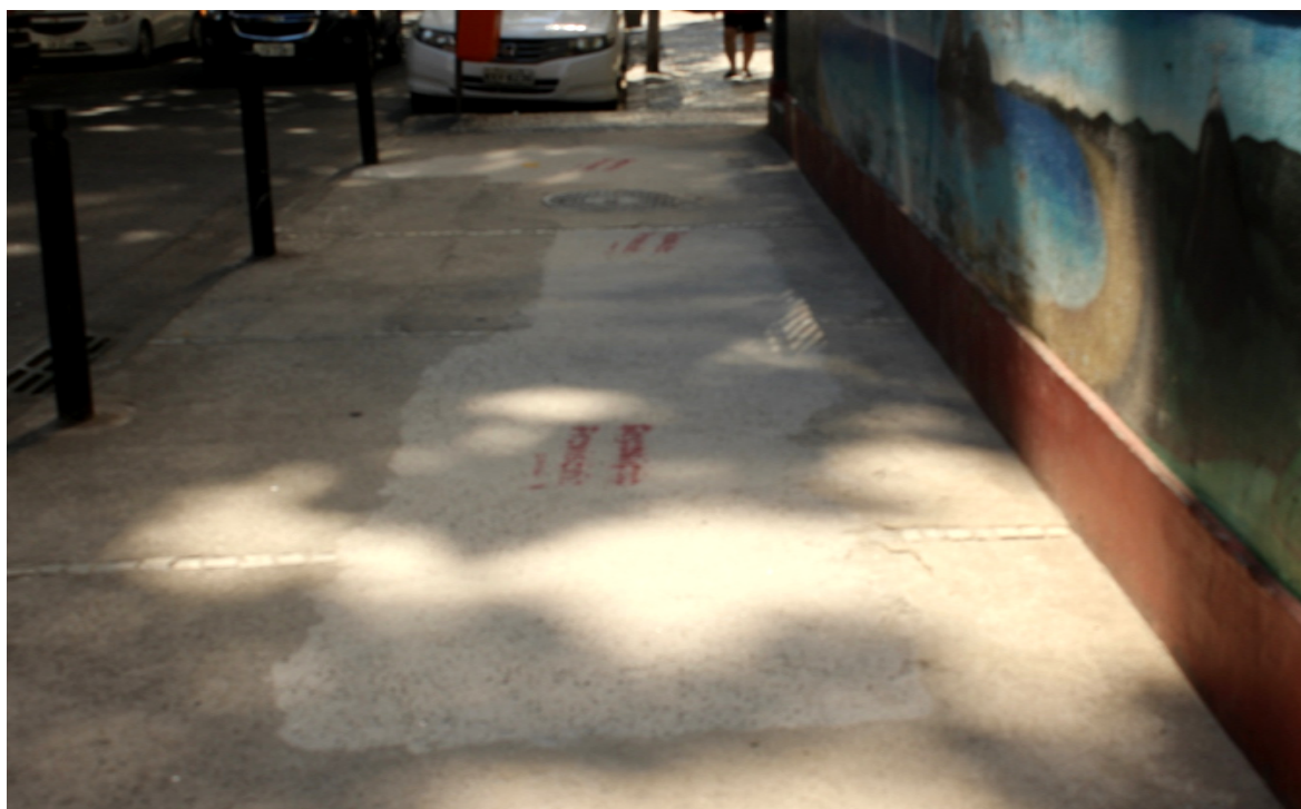
Foto 4: Recomposição provisória no passeio
