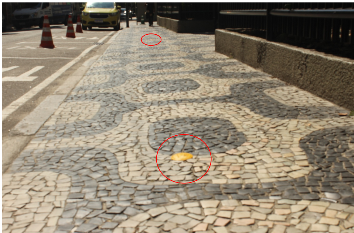
Foto 5: Marco plano indicando presença de rede de gás
