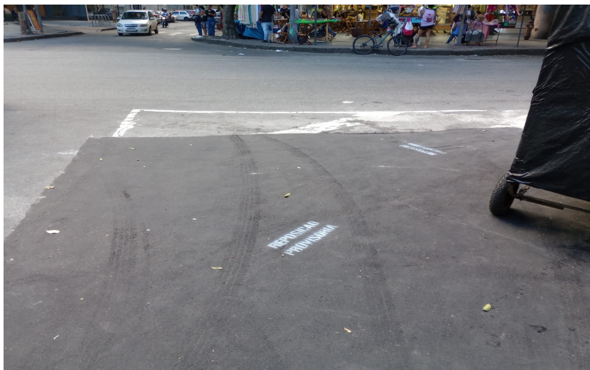
Foto 6: Identificação de recomposição provisória na via
