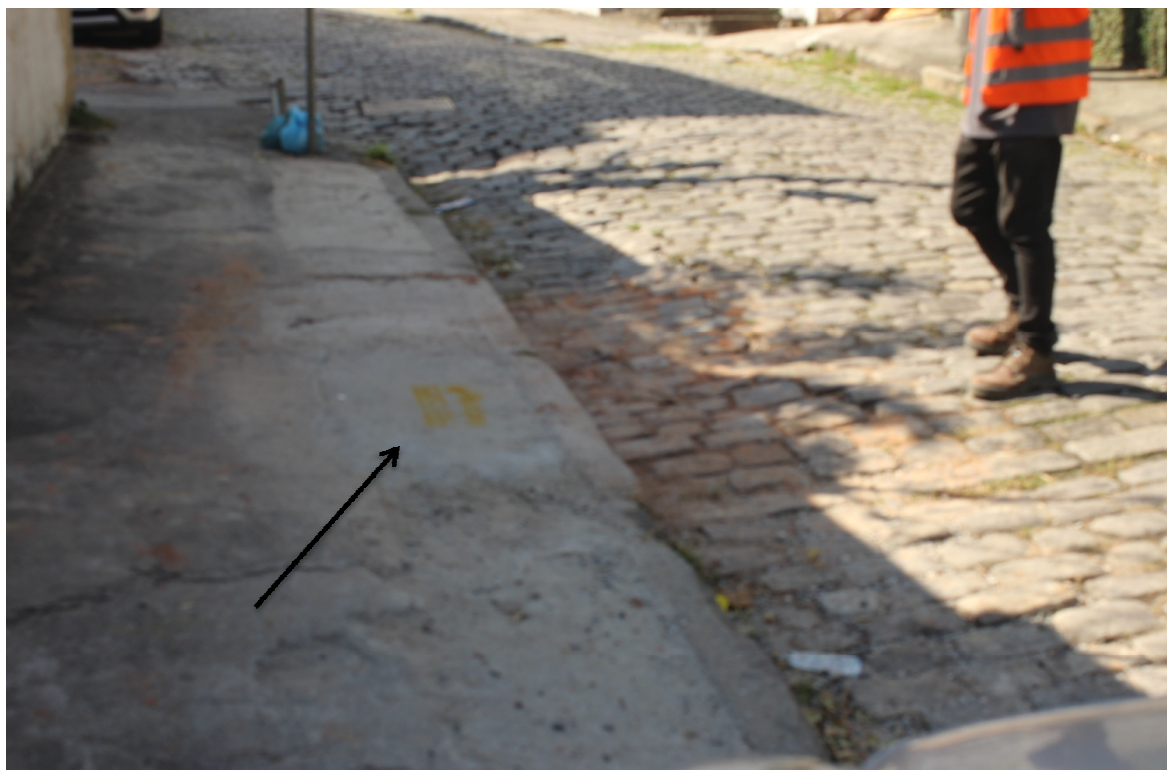
Foto 5: Recomposição no trecho finalizado lado ímpar
