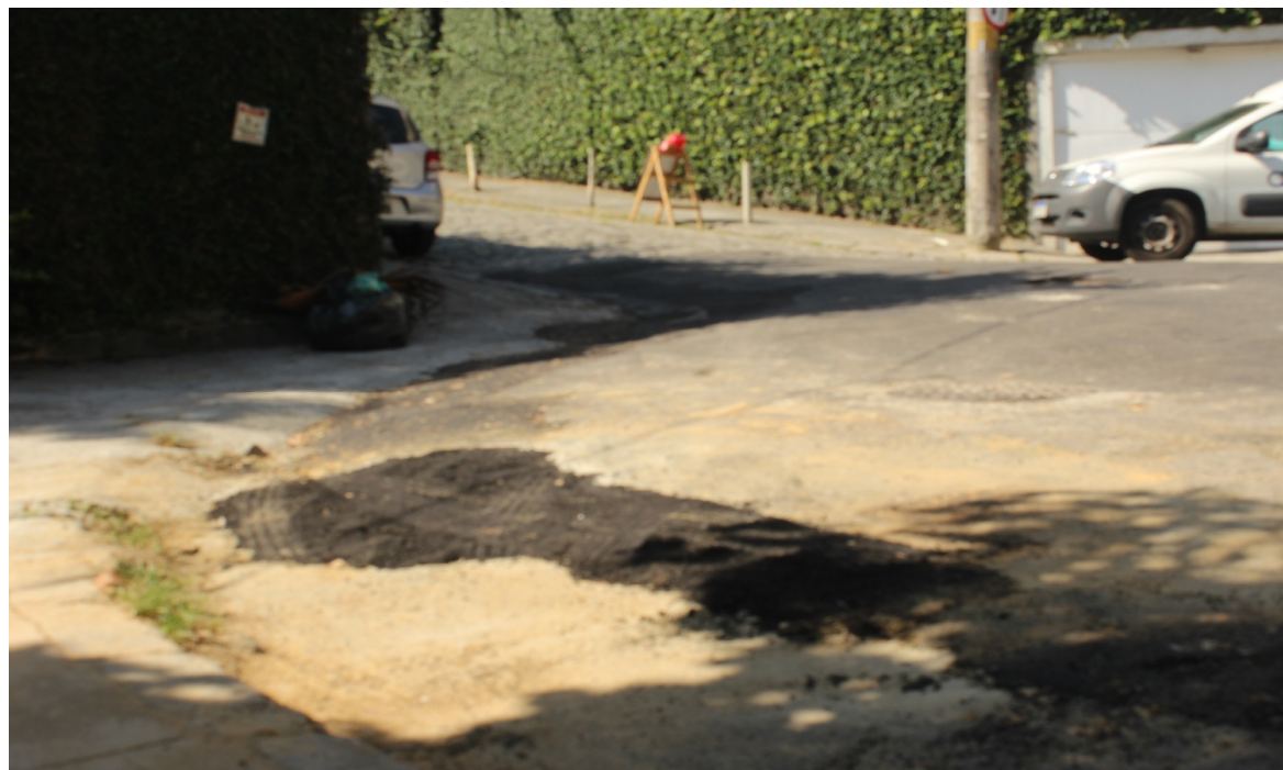
Foto 10: Recomposição provisória da via no lado ímpar
