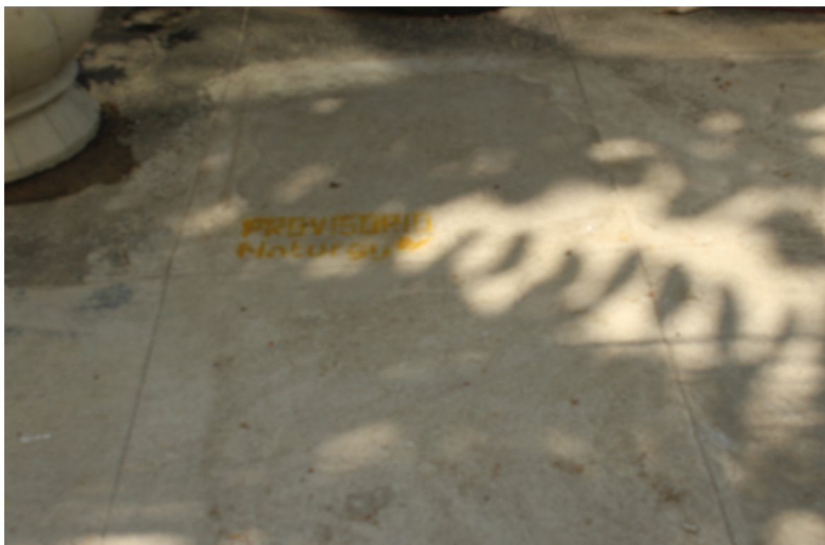
Foto 7: Recomposição provisória do passeio no lado par
