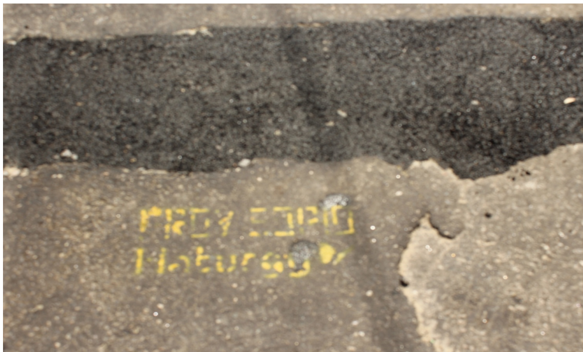
Foto 6: Recomposição provisória da via no lado par
