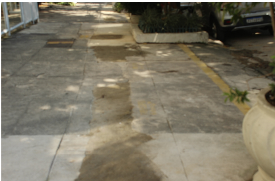
Foto 9: Recomposição provisória do passeio no lado par
