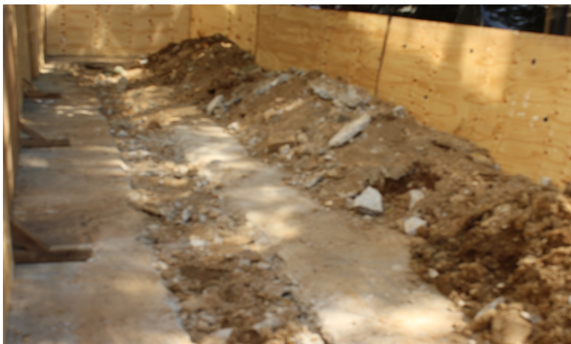
Foto 8: Reaterro de vala no passeio após assentamento de rede no lado par
