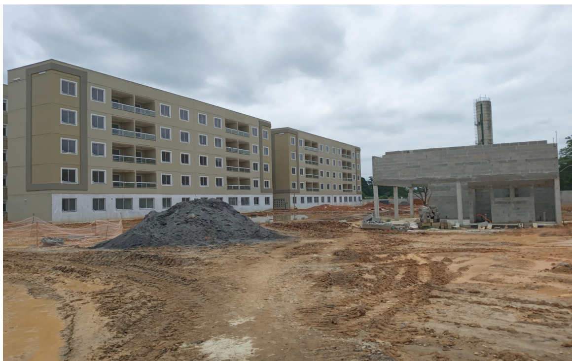
Foto 2: Situação atual das obras
