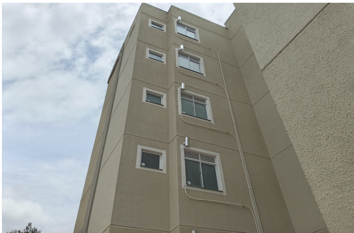
Foto 5: Ramais e chaminés dos apartamentos
