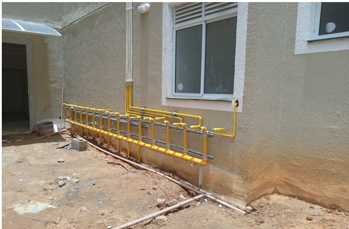
Foto 3: Local onde será construído abrigo de medidores
