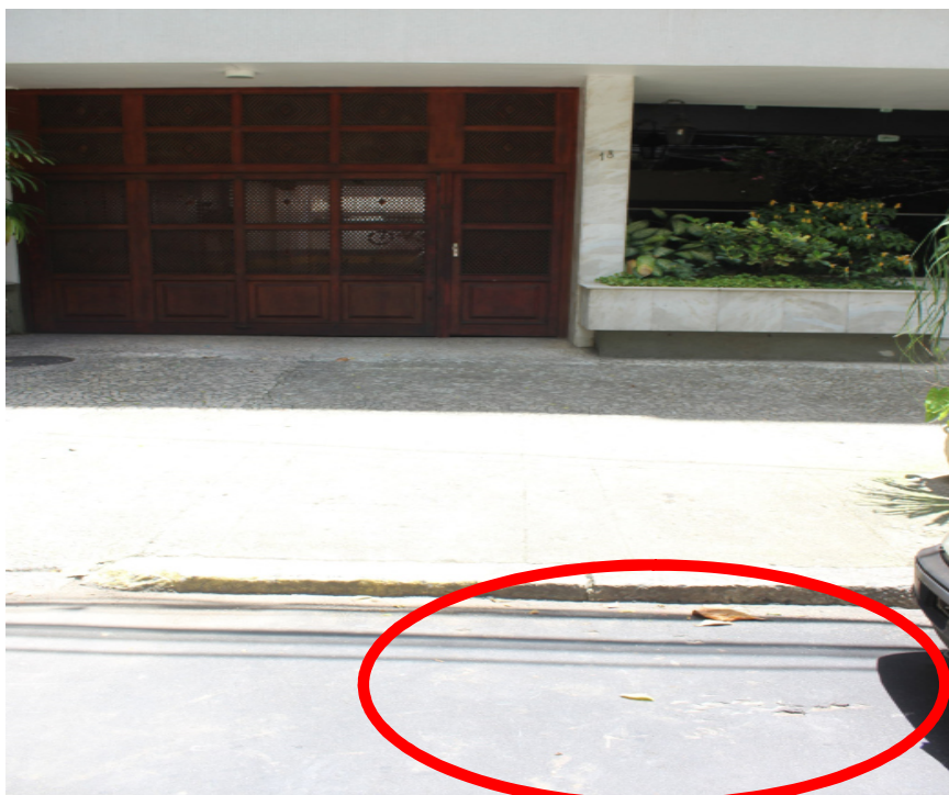
Foto 10: Recomposição com perda de material
