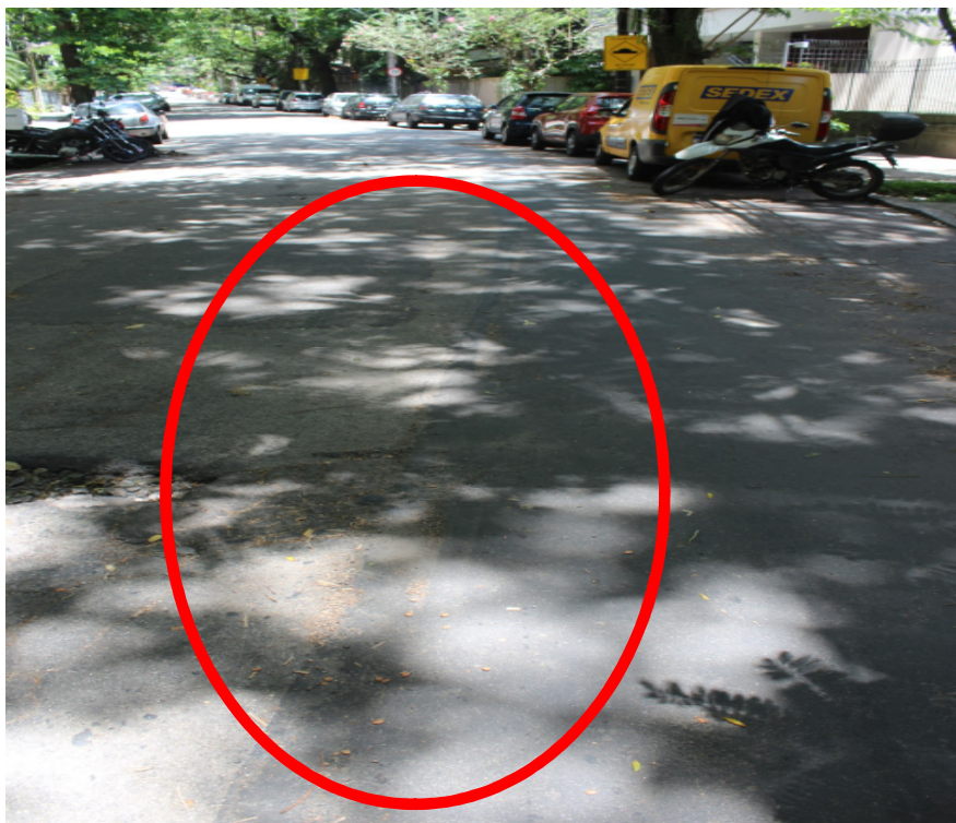
Foto 9: Recomposição com mau acabamento
