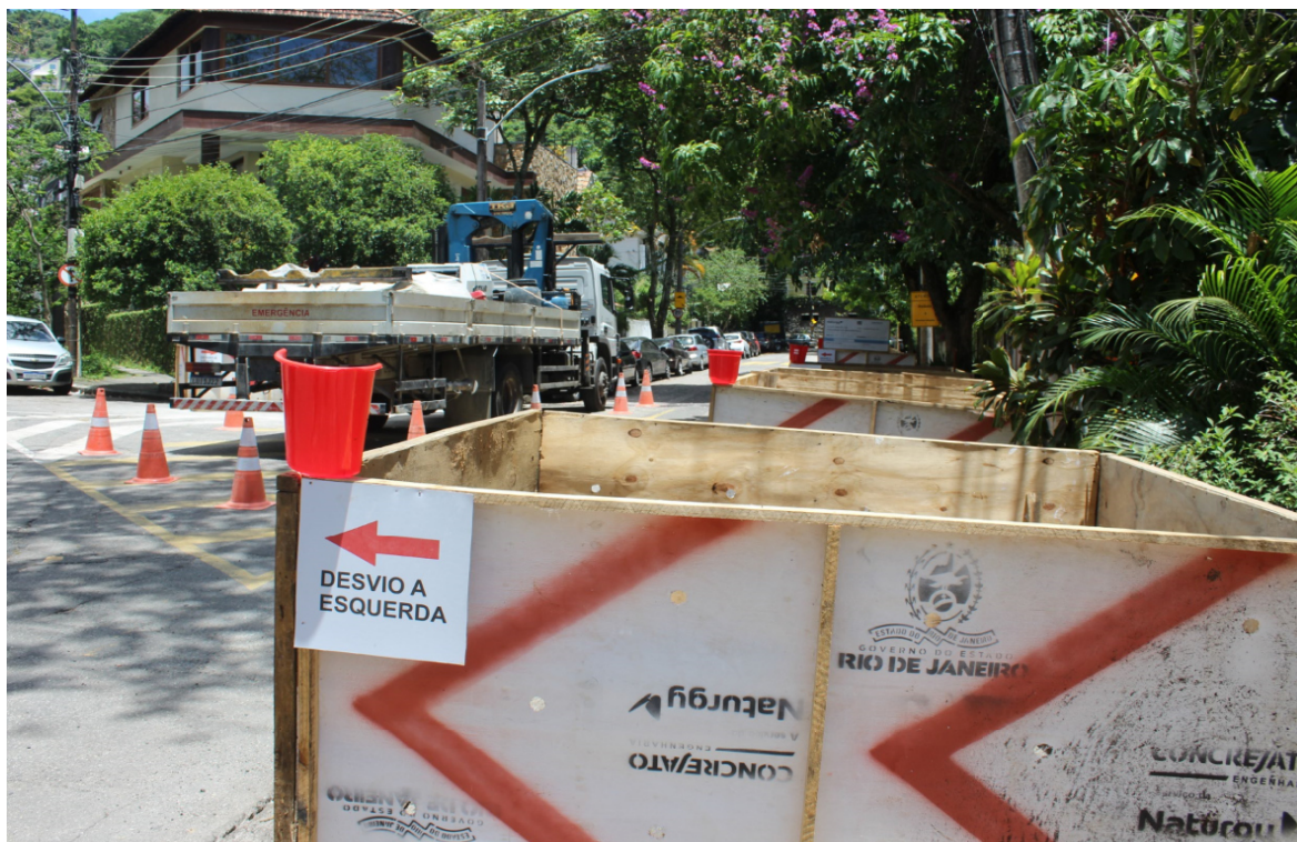
Foto 7: Sinalização de obra
