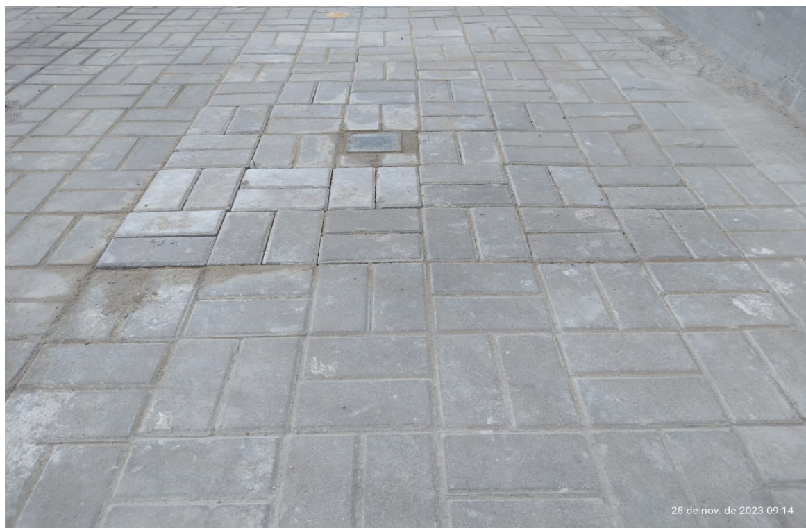
Foto 5: Piso intertravado refeito e estaca removida
