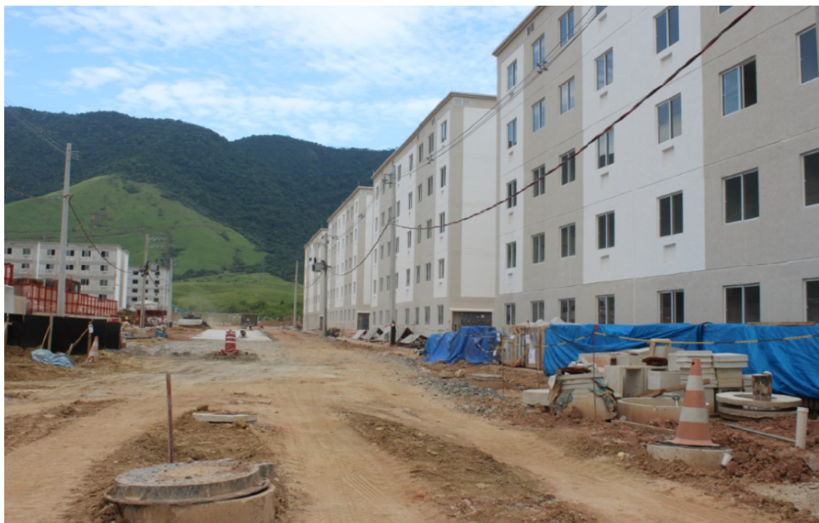
Foto 2: Situação atual das obras do condomínio
