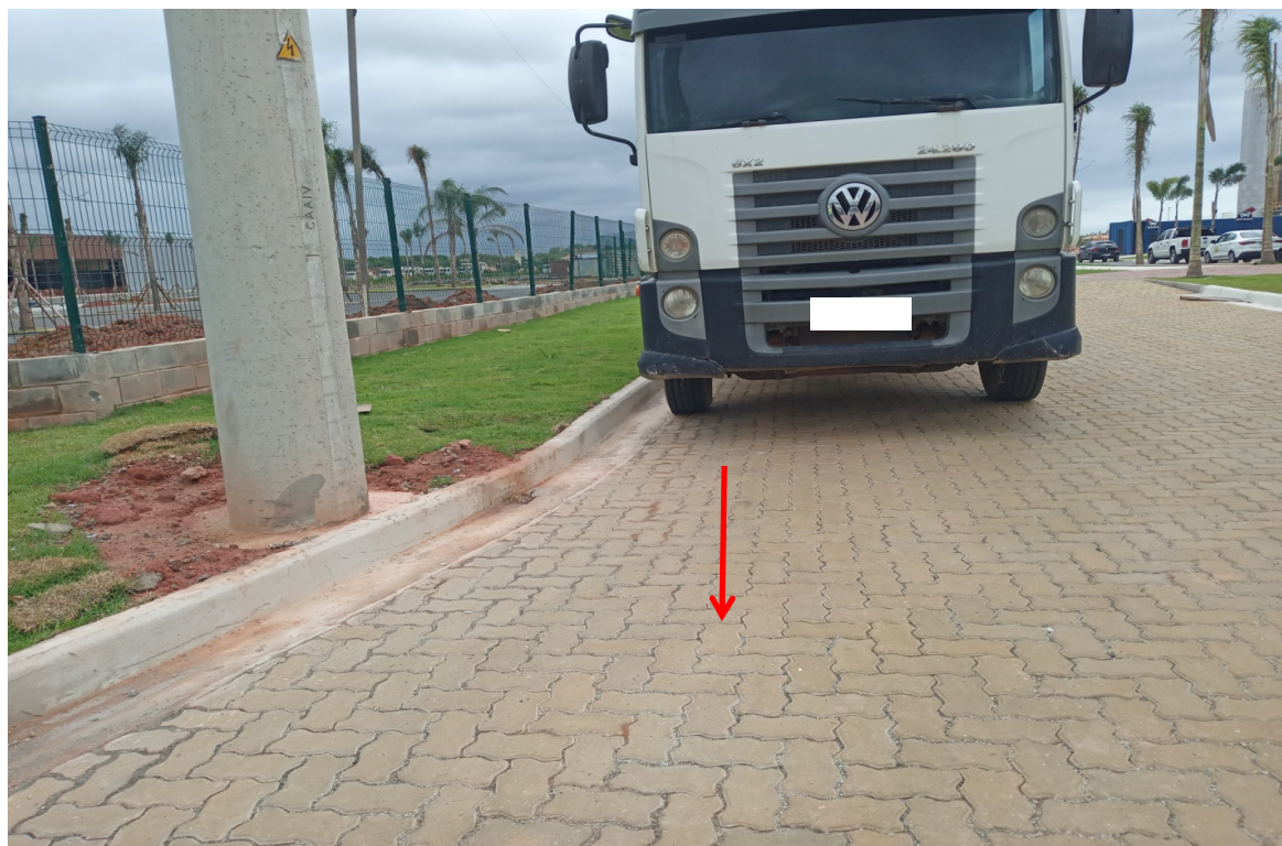
Foto 1: Ponto de início do assentamento da rede de gás natural
