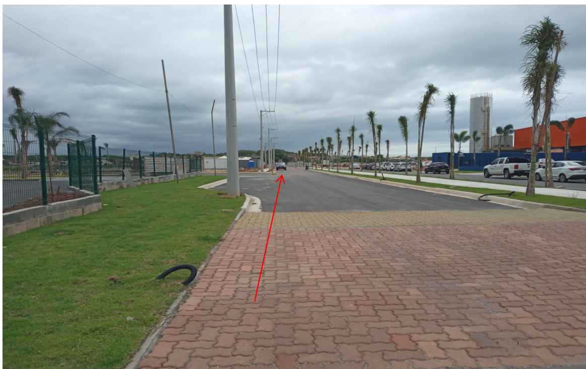
Foto 2: Trecho onde passa a rede de gás
