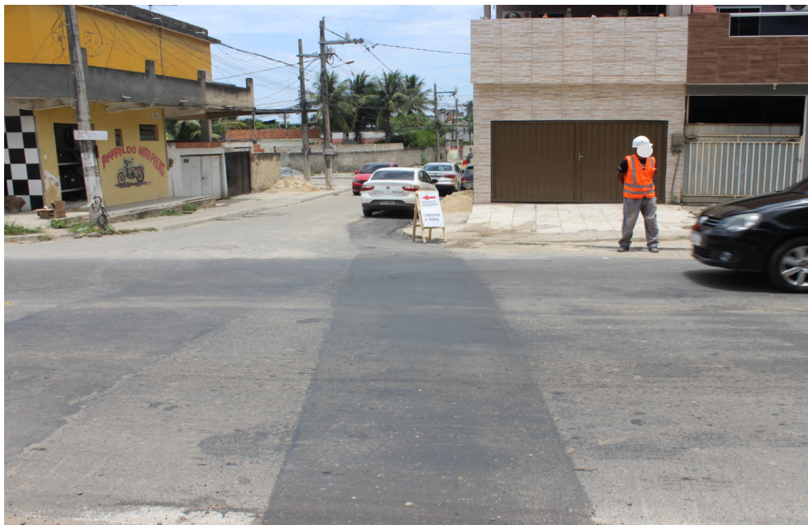
Foto 3: Recomposição em trecho de interligação
