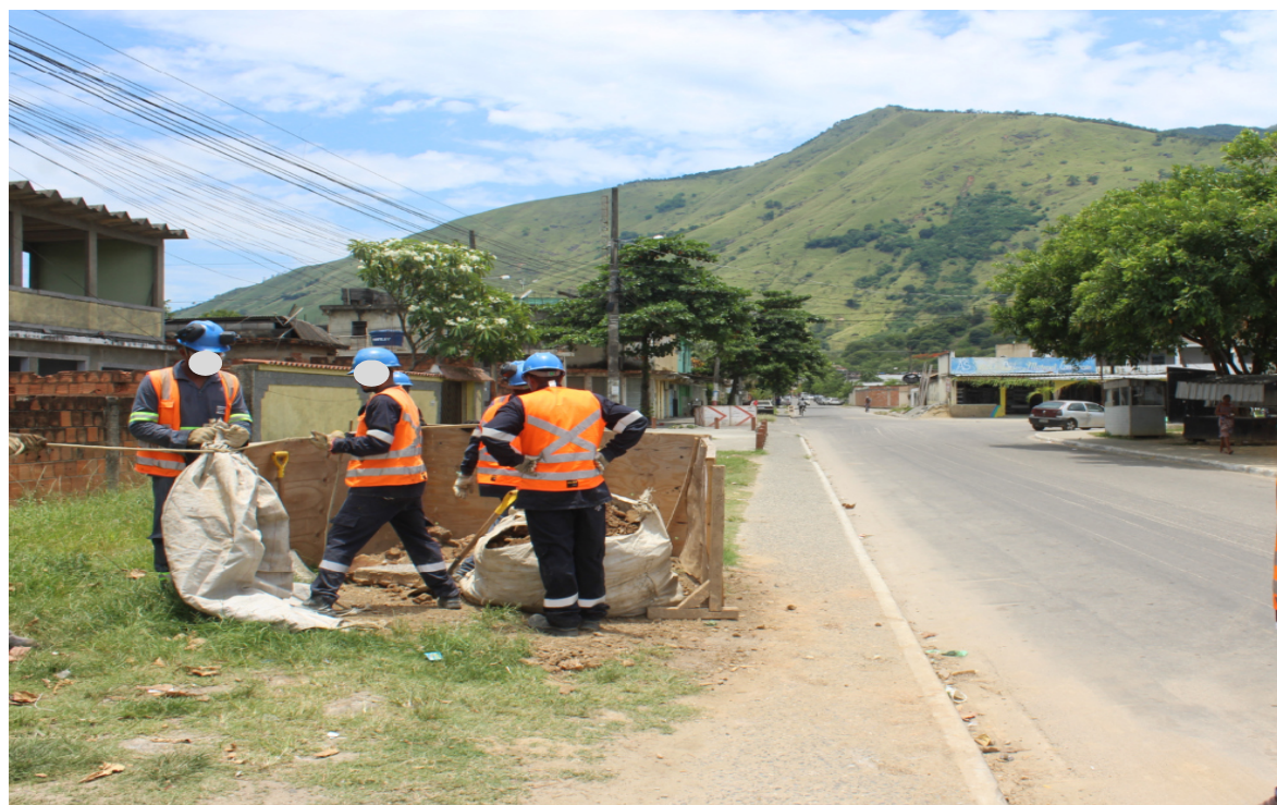
Foto 8: Equipe retirando entulho
