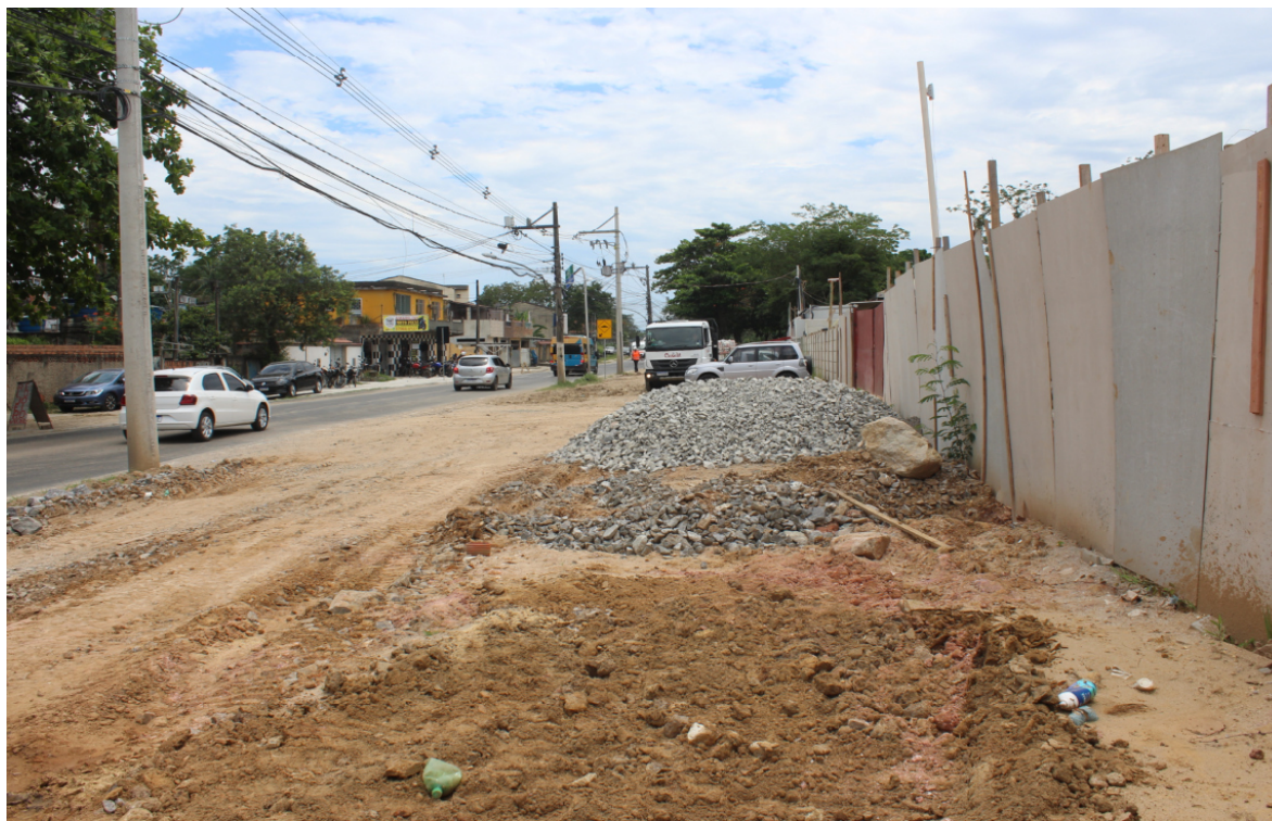
Foto 1: Ponto de início da obra
