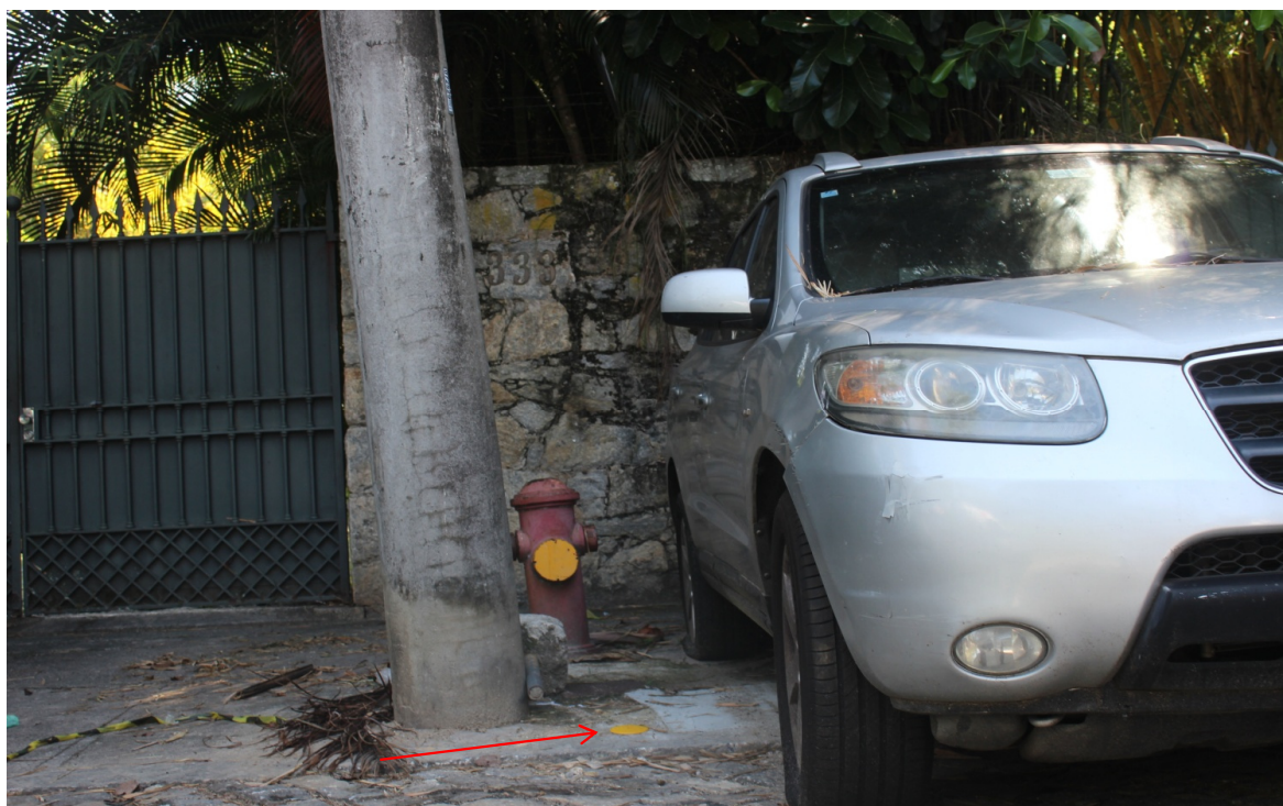
Foto 4: Recomposição e marco plano no trecho finalizado lado ímpar
