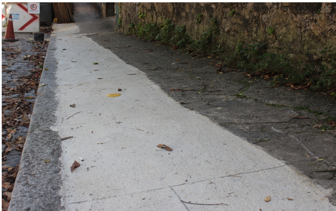
Foto 6: Recomposição e marco plano no trecho finalizado lado ímpar
