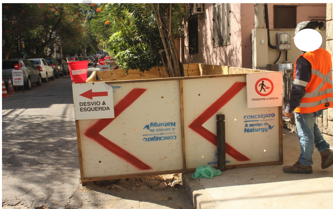
Foto 10: Isolamento e sinalização
