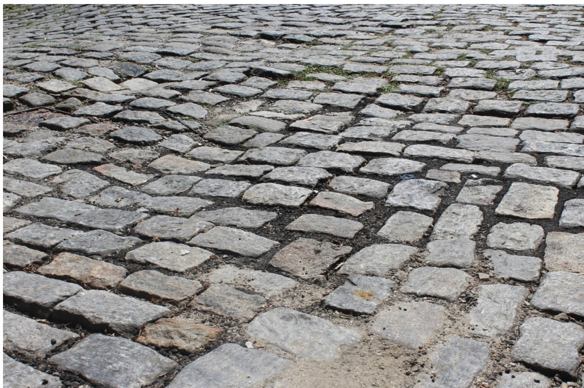
Foto 5: Recomposição no trecho finalizado lado ímpar
