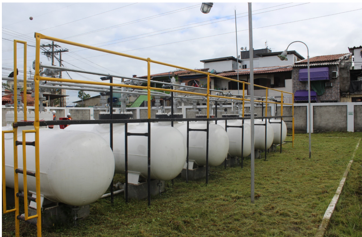
Foto 13: Pintura e conservação estrutural
