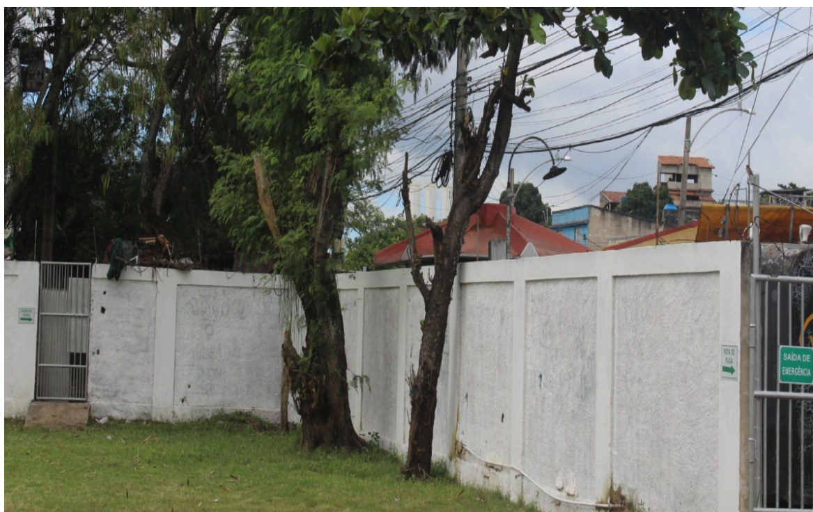
Foto 10: Concertinas danificadas e em mau estado
