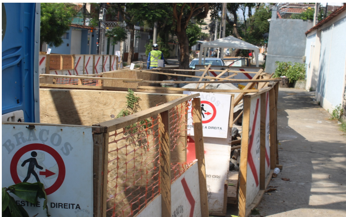
Foto 2: Trechos par e ímpar da Rua Aquidabã evidenciando barreiras e sinalizações de desvio de pedestre
