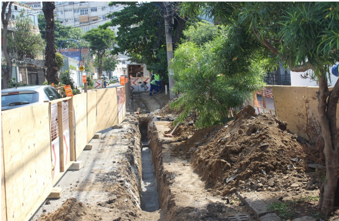
Foto 5: Trecho da via aberto para assentamento de rede
