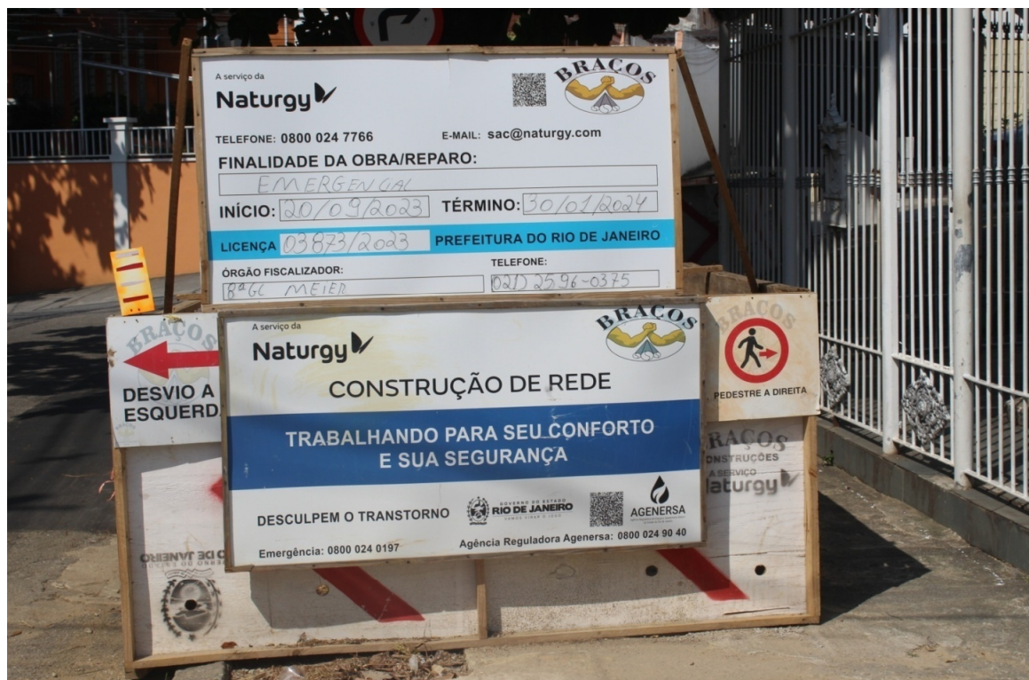
Foto 1: Placa de identificação da obra na esquina da R. Aquidabã com a R. Dona Claudina
