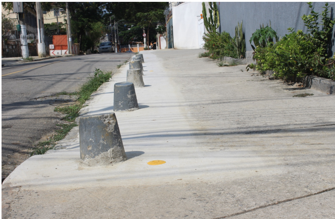
Foto 3: Trecho ímpar da R. Aquidabã com recomposição definitiva e presença de marco plano
