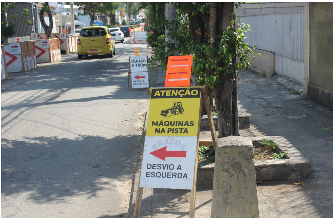
Foto 6: Placas de sinalização para desvio e máquinas na pista no trecho par da Rua Aquidabã
