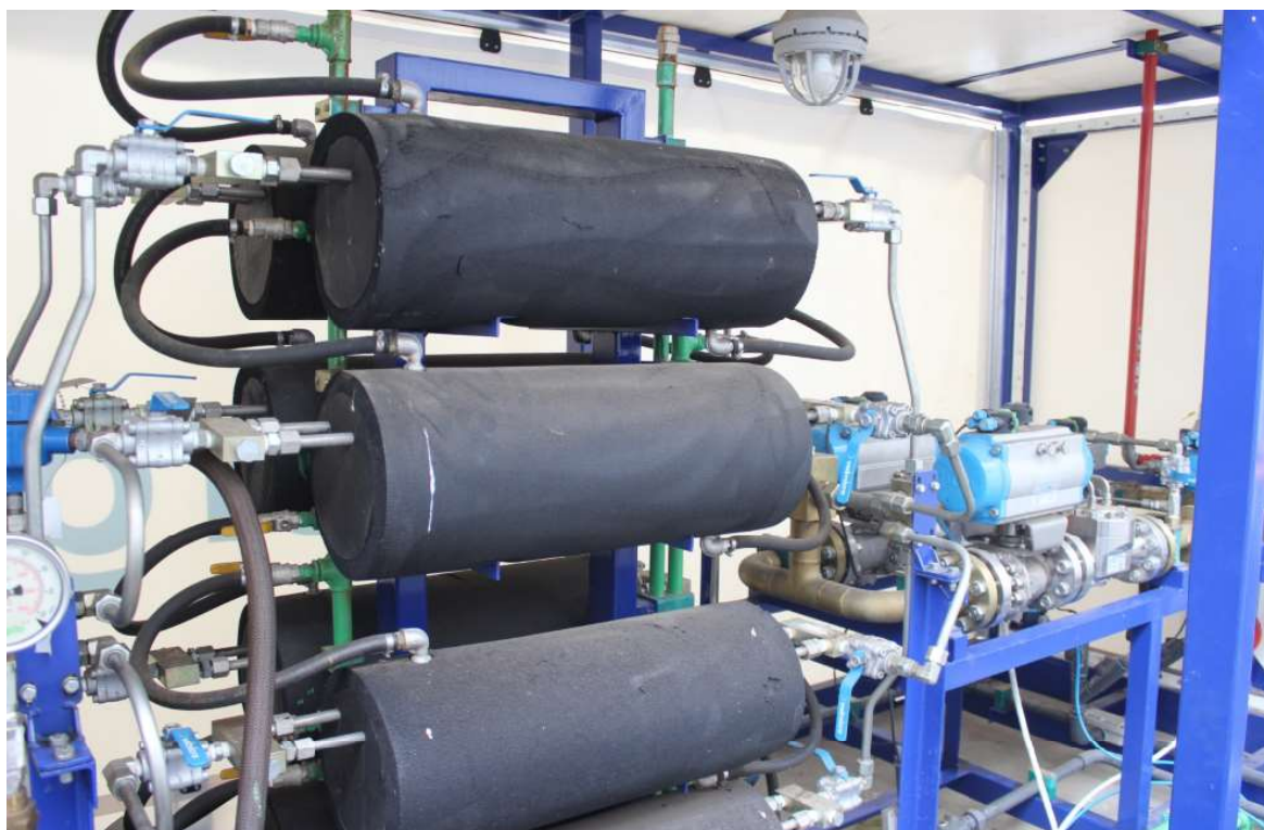
Foto 7: Trocadores de calor e reguladores de 2º estágio
