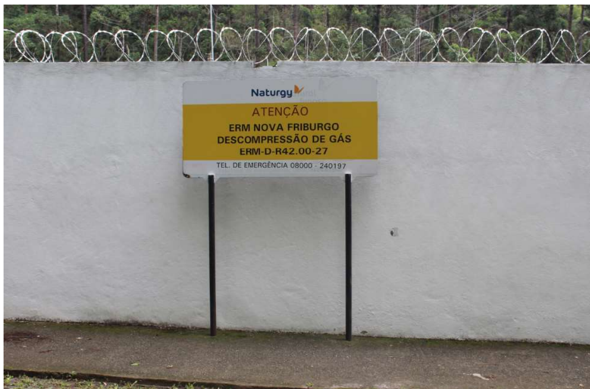
Foto 1: Placa de identificação da estação
