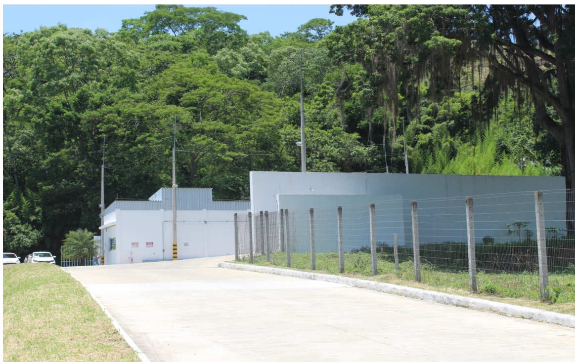
Foto 2: Vista geral da estação
