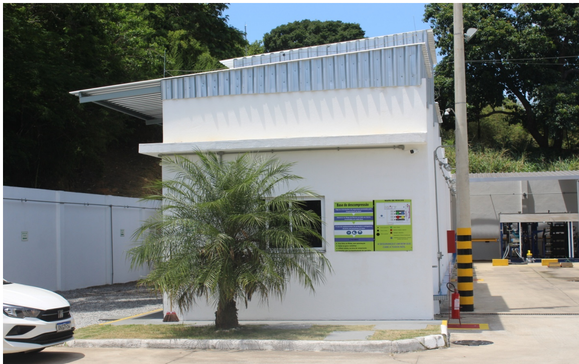
Foto 3: Salas de operação e controle
