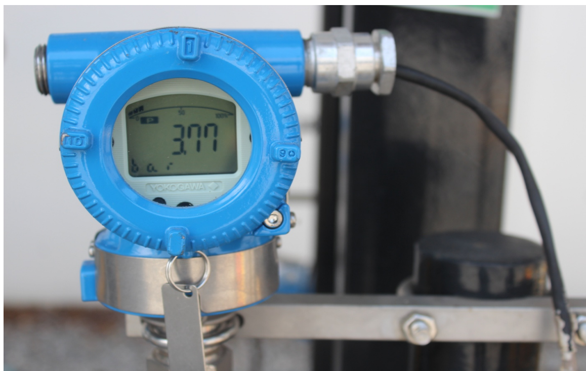
Foto 10: Medição da pressão a jusante do regulador
