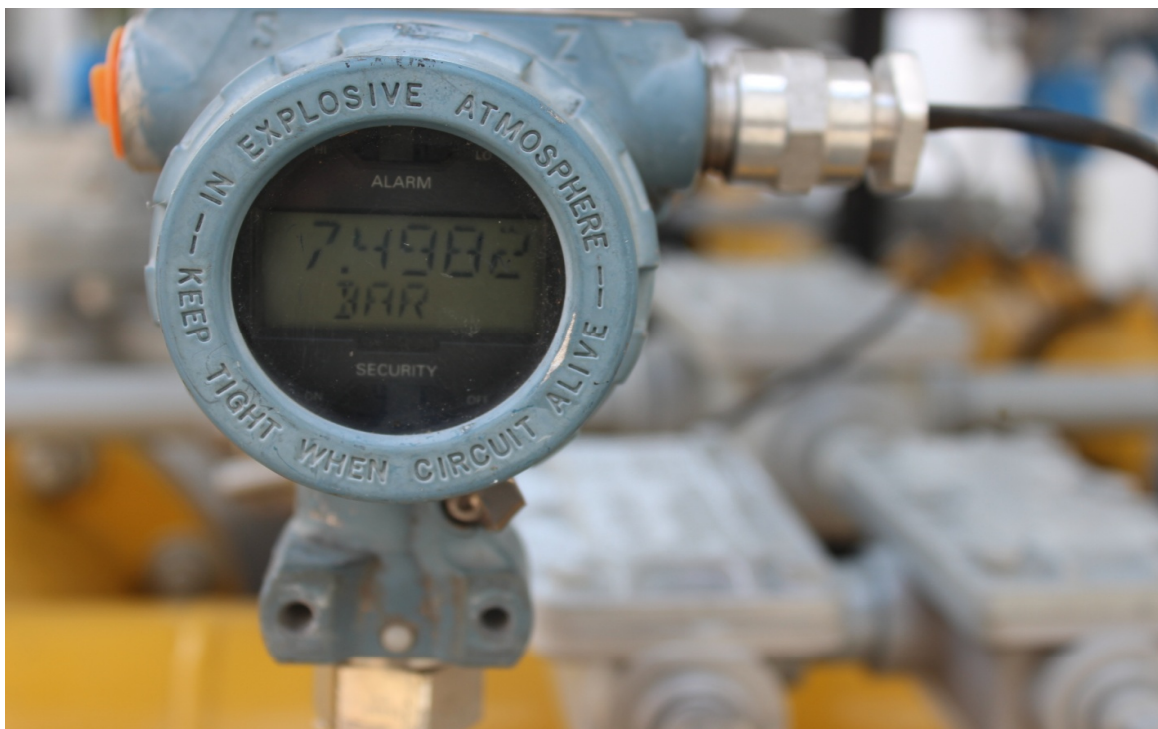
Foto 9: Medição da pressão a montante do regulador
