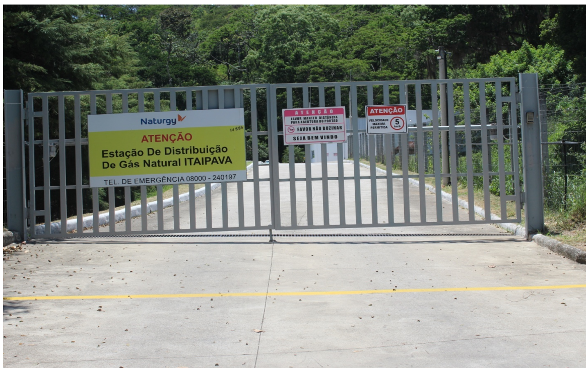
Foto 1: Identificação e acesso à estação de descompressão
