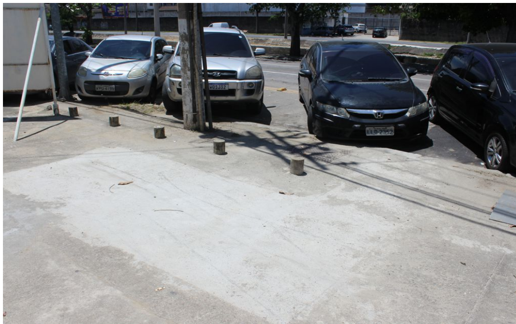
Foto 9 : Recomposição da calçada.
