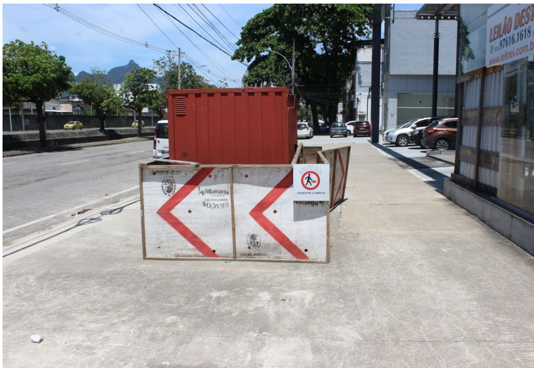
Foto 6 : Área de armazenamento de materiais.
