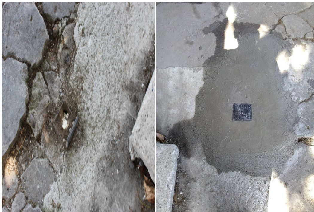
Foto 8 : Troca da caixa que aloja a válvula de segurança (antes e depois).
