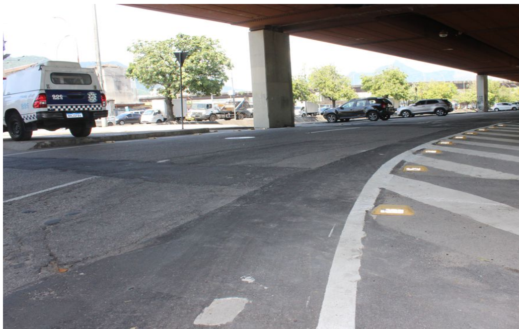
Foto 3 : Recomposição asfáltica da obra na rua Francisco Eugênio n.º 300.
