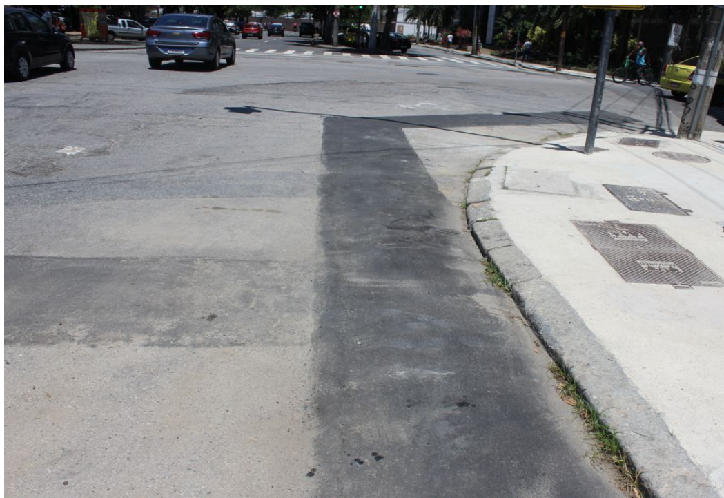
Foto 10 : Recomposição provisória na rua São Crisatovão.
