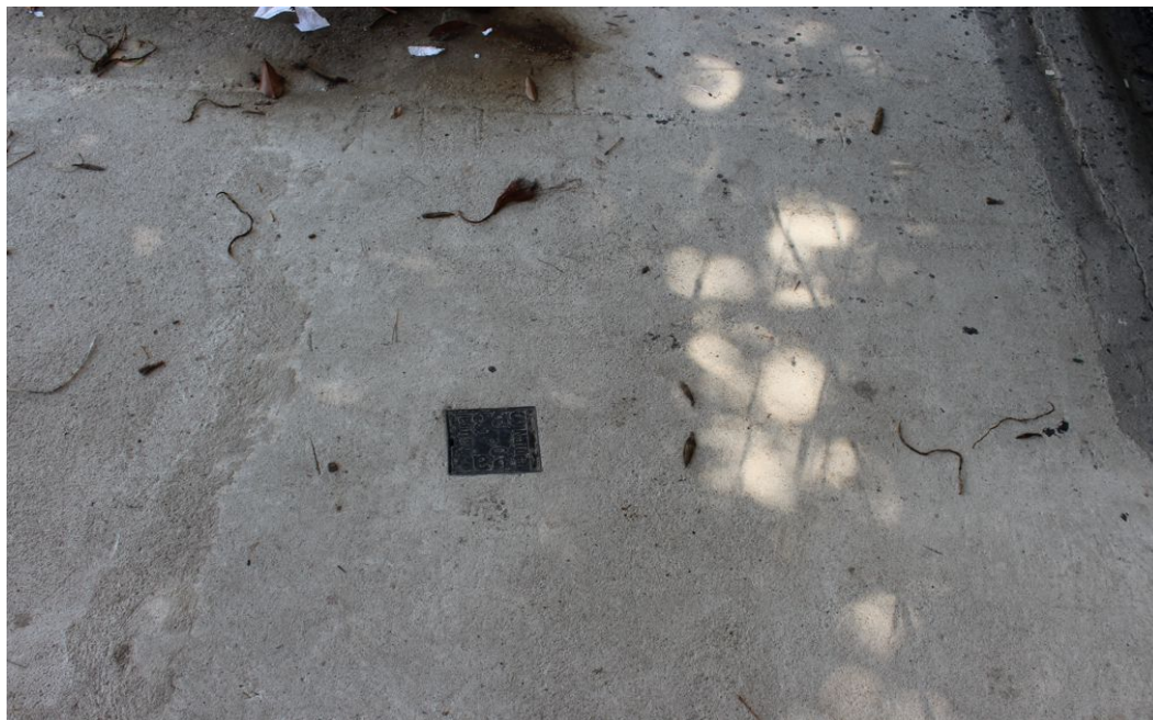
Foto 7 : Caixa de alojamento da válvula de segurança.
