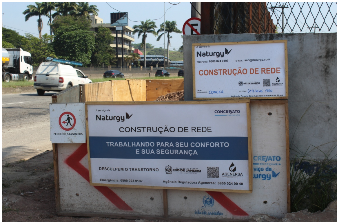
Foto 1: Ponto de início da obra contendo placa de identificação
