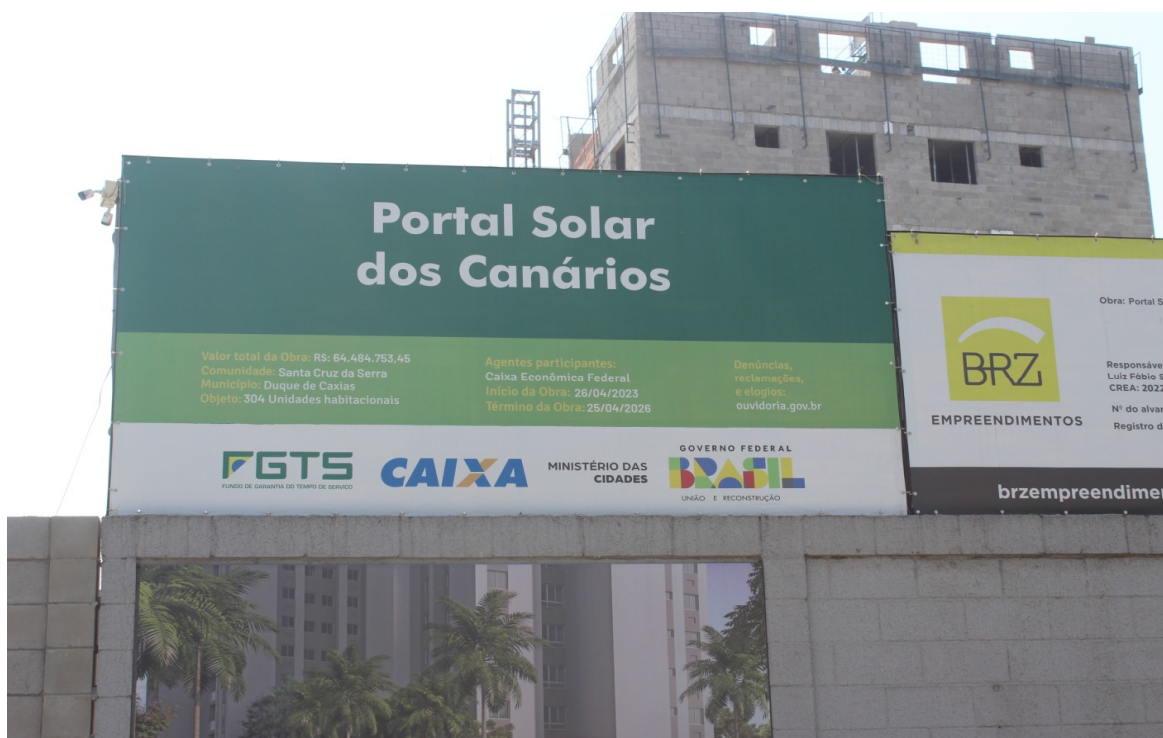
Foto 2: Empreendimento imobiliário Portal Solar dos Canários (em fase de construção)
