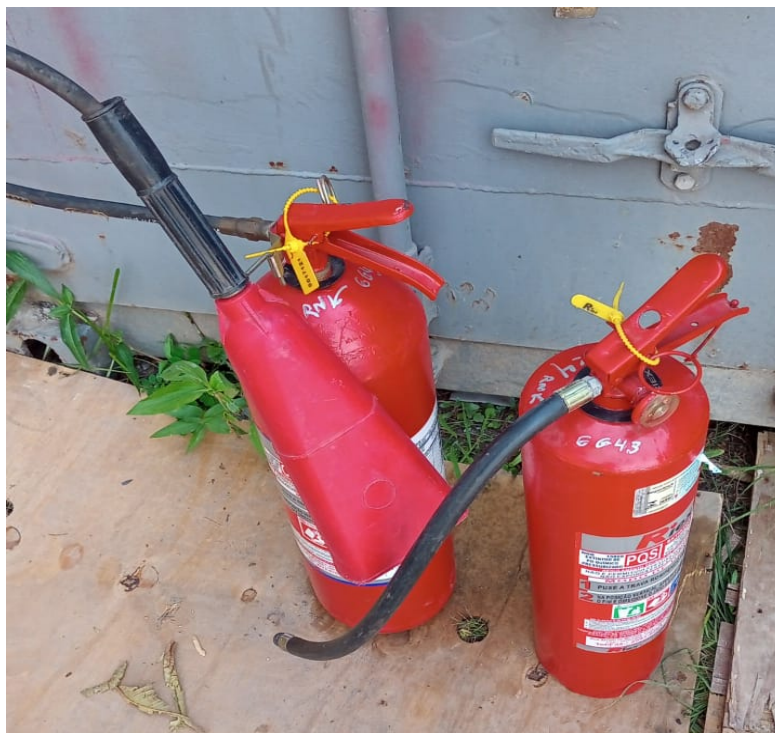
Foto 8: Substituição de extintor de CO2 (observar lacre intacto)
