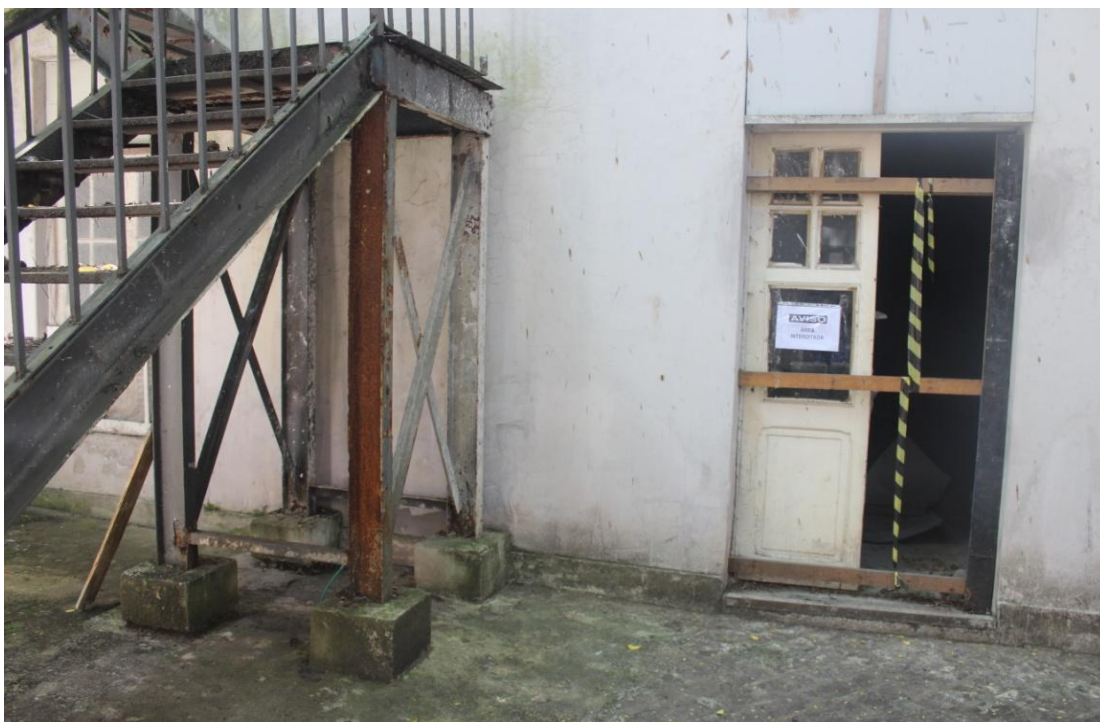
Figura 5 – Escada metálica de acesso aos fundos ao pavimento superior da ala direita.
