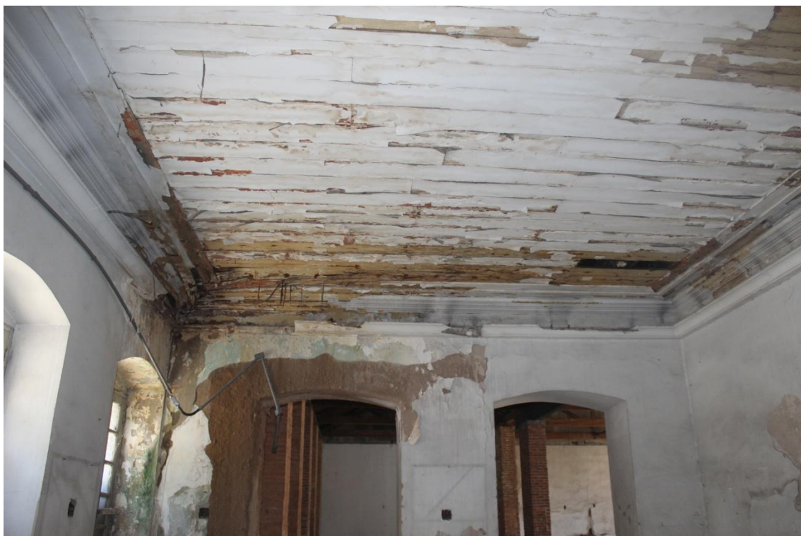
Figura 17 – Forro do andar térreo da ala esquerda.
