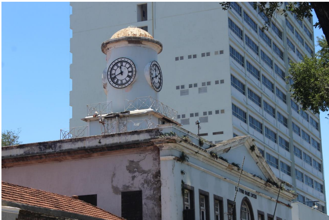
Figura 24 – Fachada e Torre do relógio.
