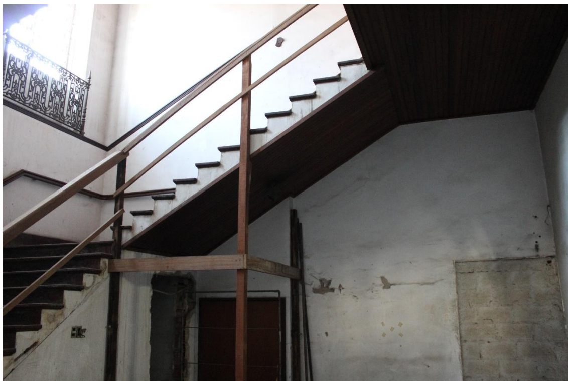
Figura 21 – Escada de madeira de acesso à ala esquerda superior.
