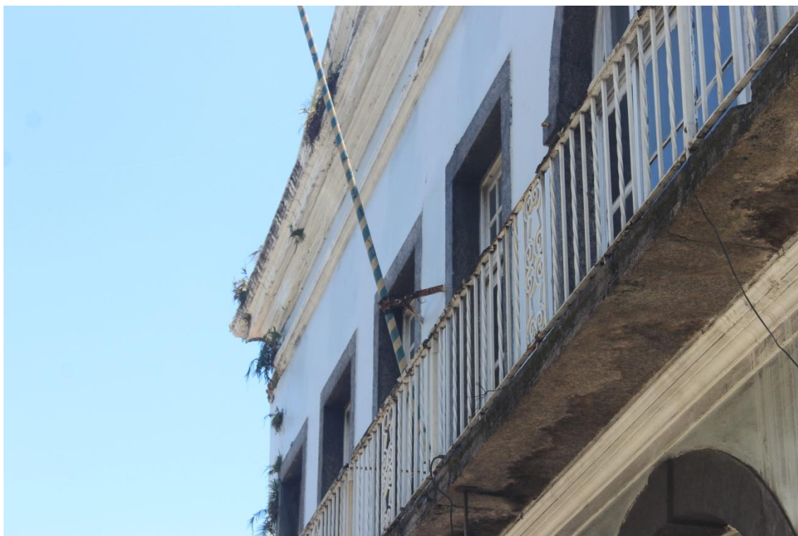
Figura 27 – Suporte metálico do mastro.
