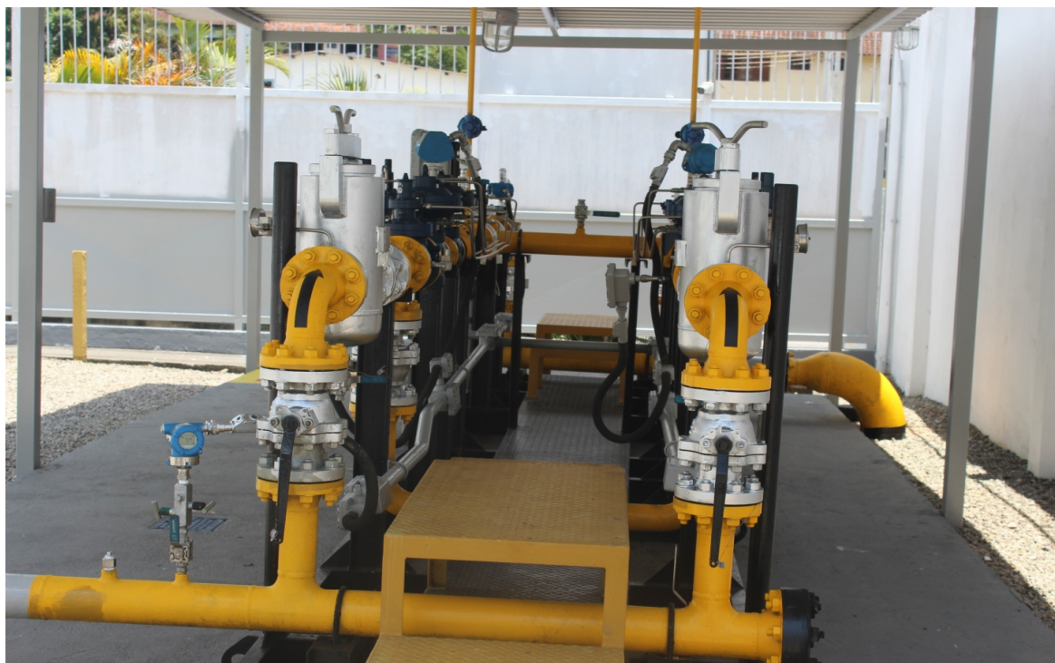
Foto 7: Regulagem e medição (entrada)
