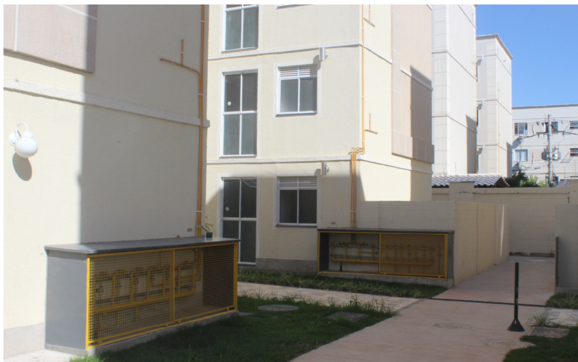
Foto 3: Instalação de ramal para rede interna
