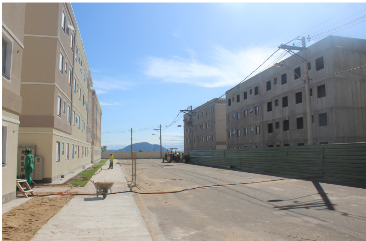
Foto 2: Situação atual das obras do condomínio
