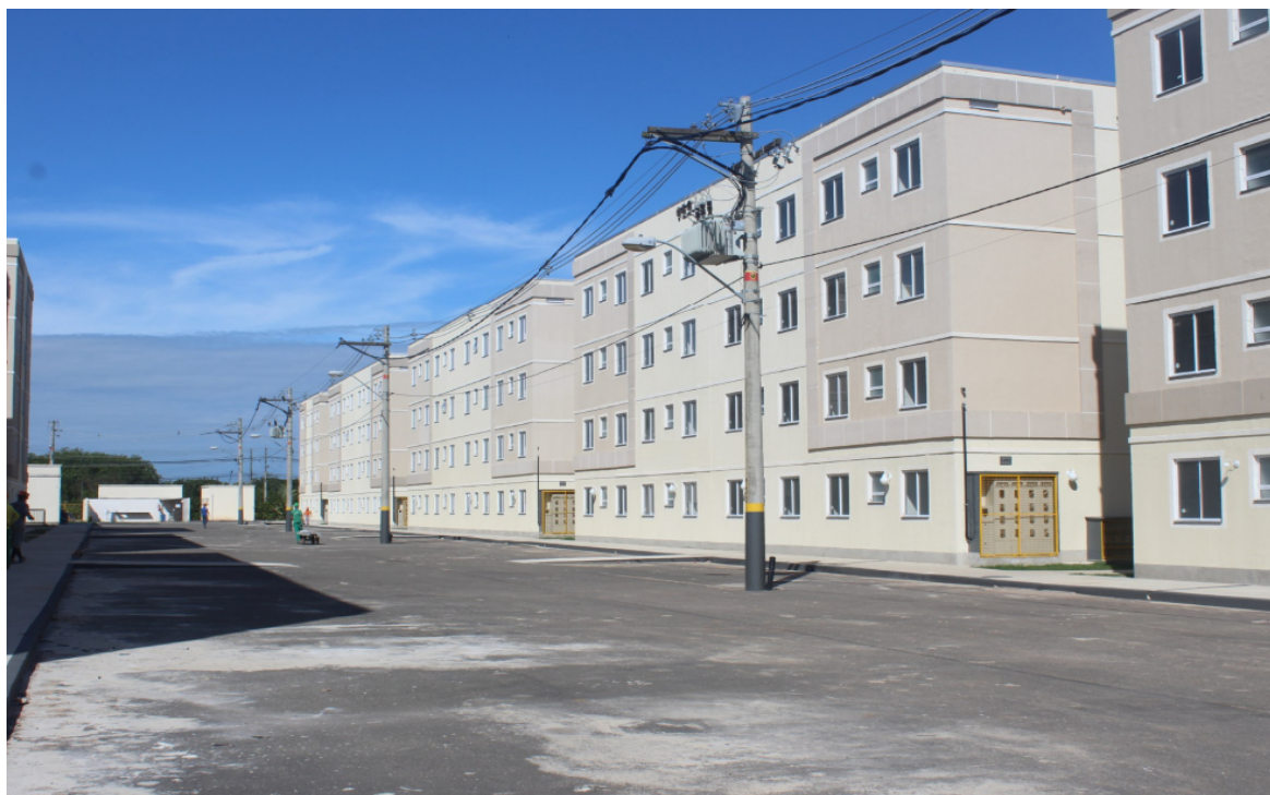
Foto 1: Fachada do condomínio
