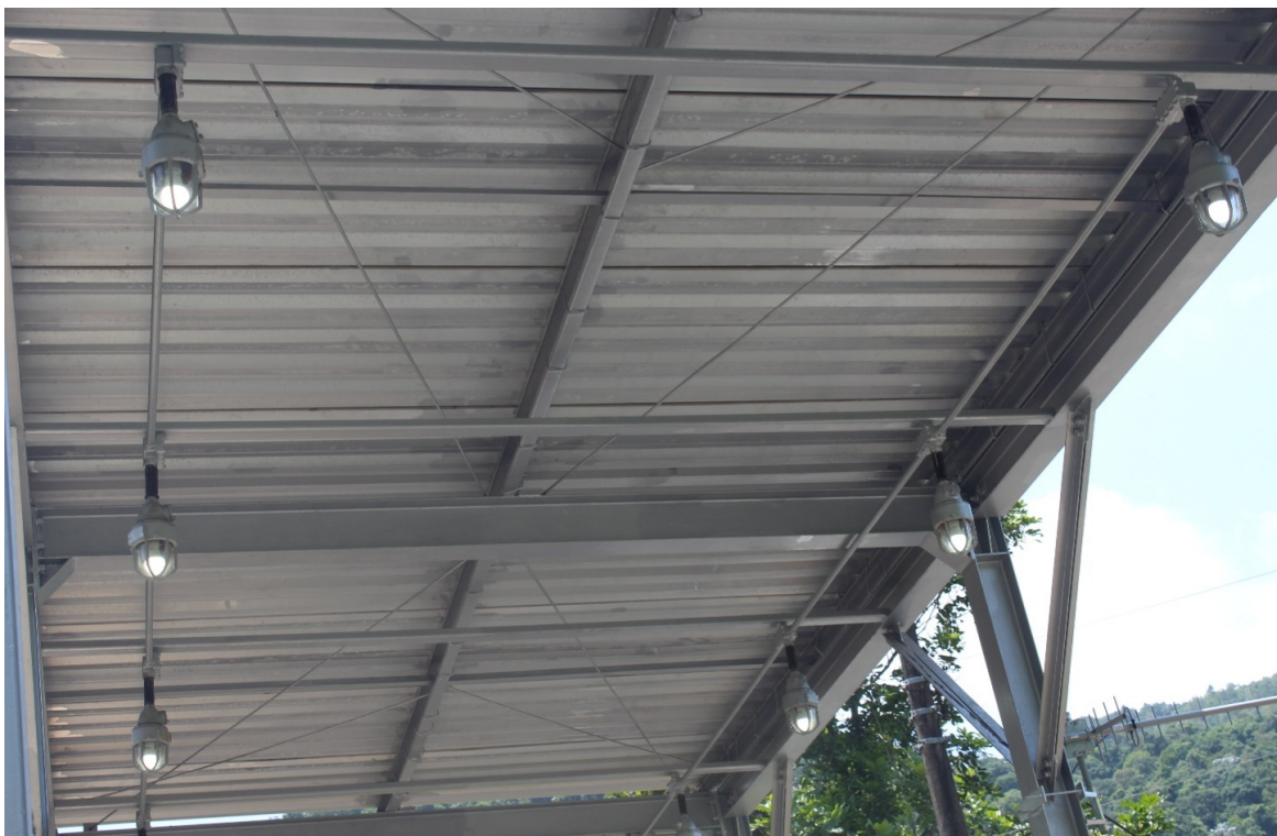
Foto 8: Cobertura da estação
