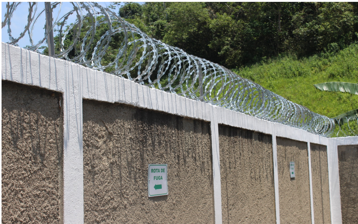
Foto 9: Sinalização de rota de fuga
