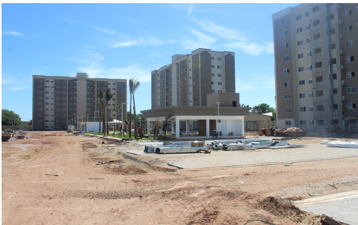
Foto 2: Situação atual das obras do condomínio
