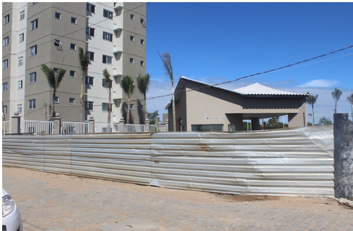
Foto 1: Fachada do condomínio
