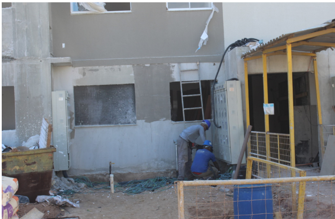
Foto 5: Instalação de ramal para rede interna
