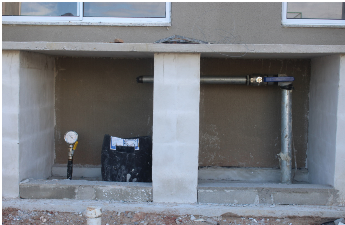
Foto 3: Instalação de ramal para rede interna
