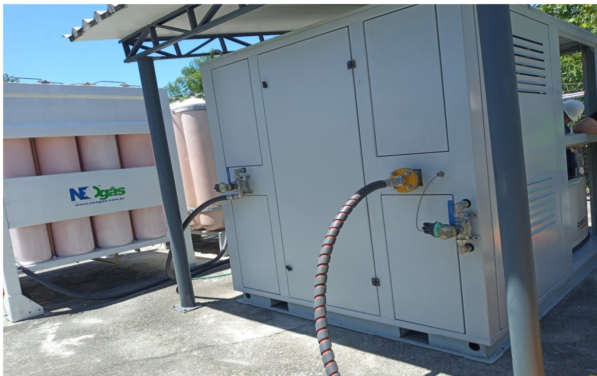
Foto 5: Unidade de Controle e Redução
