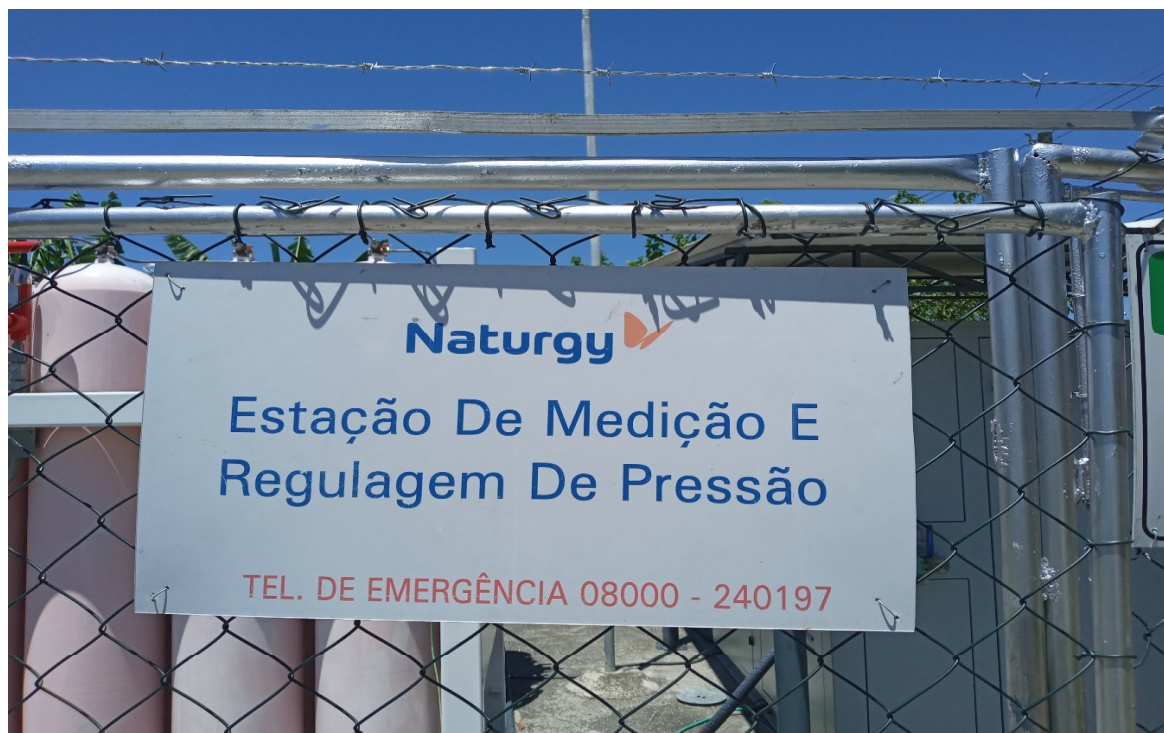
Foto 1: Placa de identificação da estação
