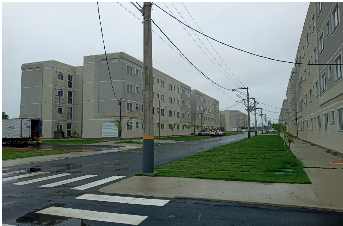
Foto 7: Situação atual - blocos já entregues
