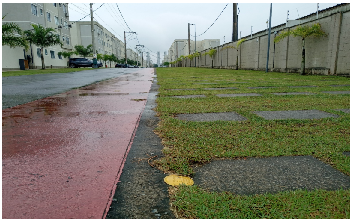
Foto 2: Marco plano - entrada da rede de gás
