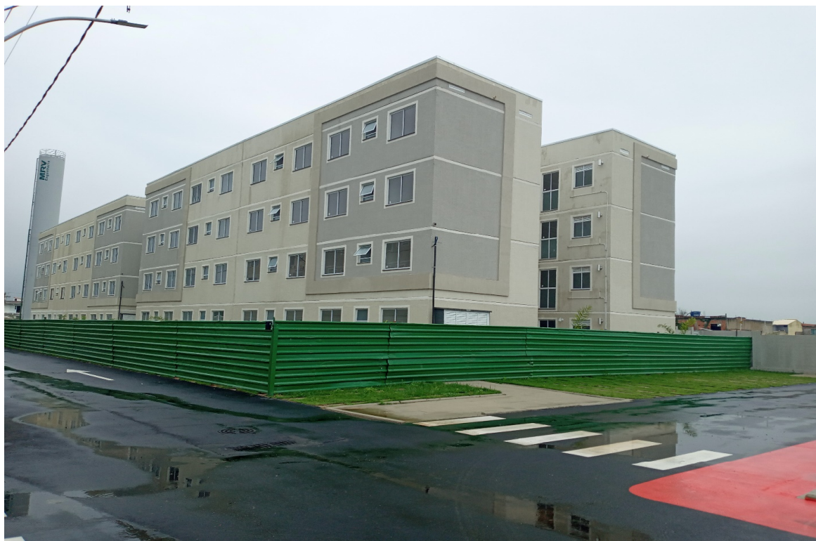
Foto 9: Blocos ainda em construção
