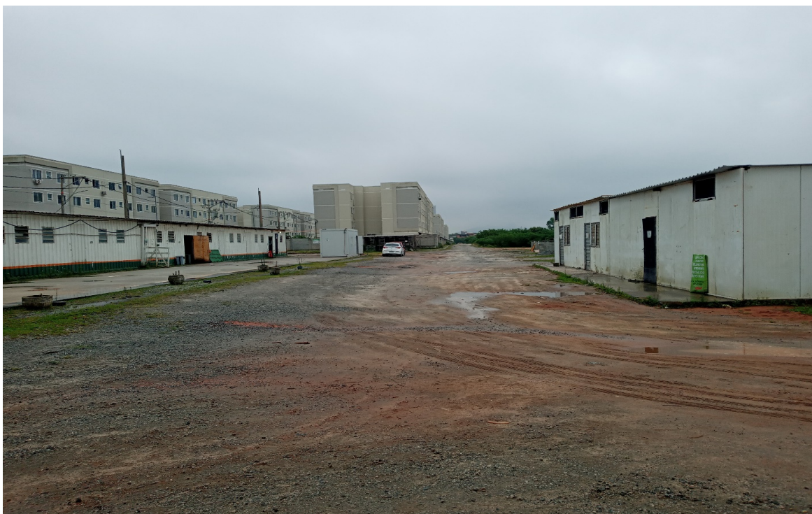
Foto 10: Canteiro de obras - Construtora RMV
