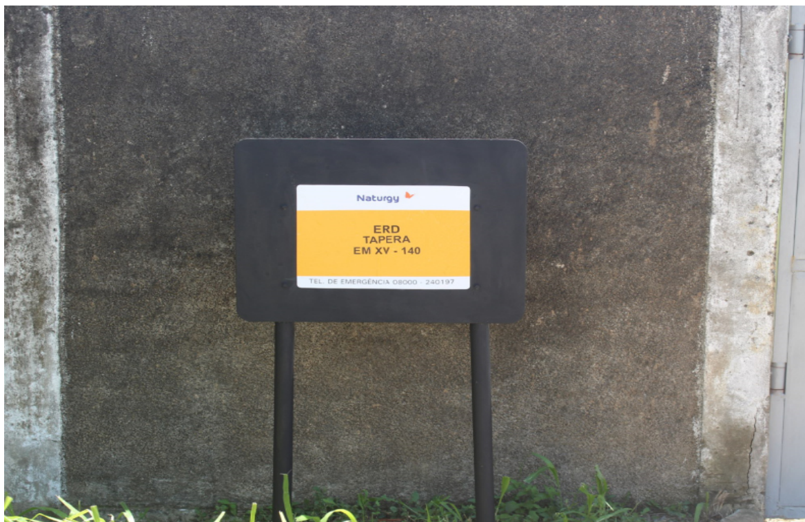
Foto 1: Placa de identificação da Estação
