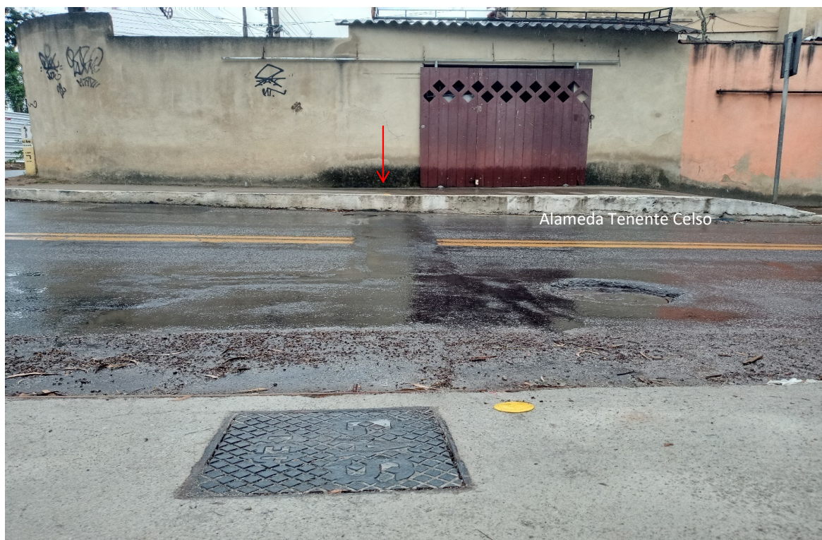
Foto 1: Ponto de início da obra (a interligar)
