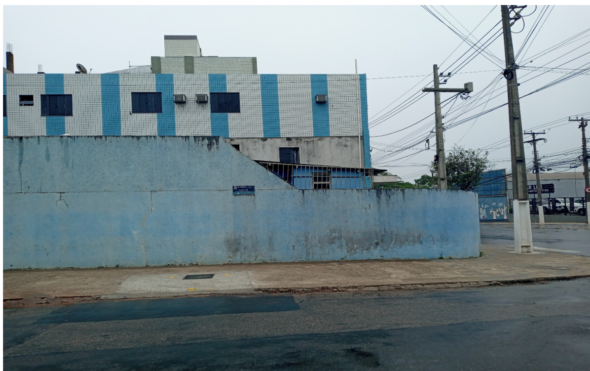
Foto 6: Ponto onde a rede se encontra capeada
