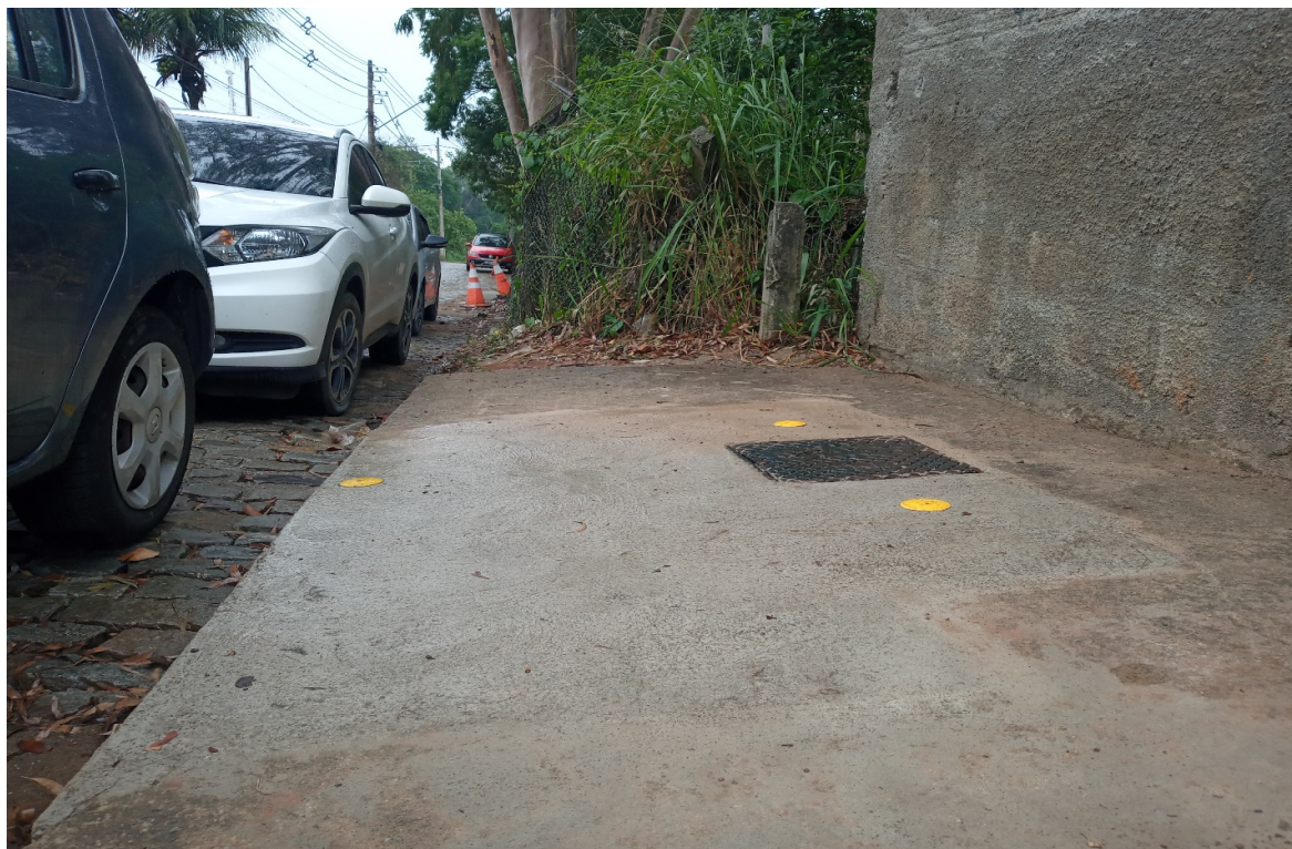
Foto 5: Recomposição do passeio e válvula de setor
