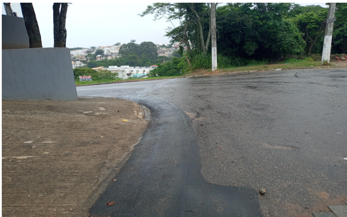
Foto 6: Recomposição de trecho realizado em vala aberta
