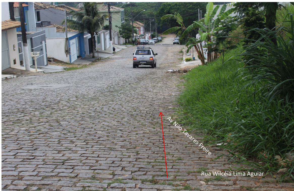
Foto 1: Ponto de início da obra
