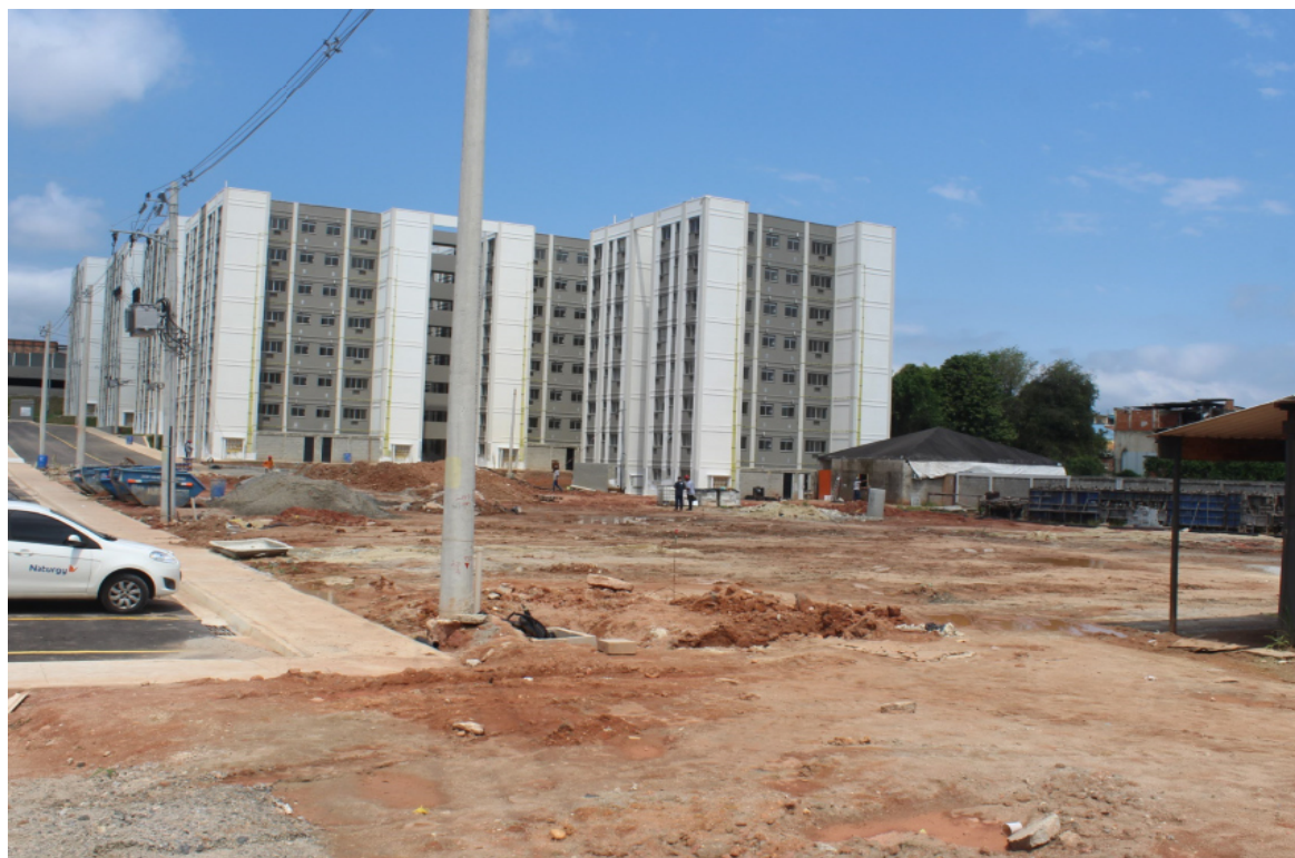
Foto 2: Situação atual das obras do condomínio
