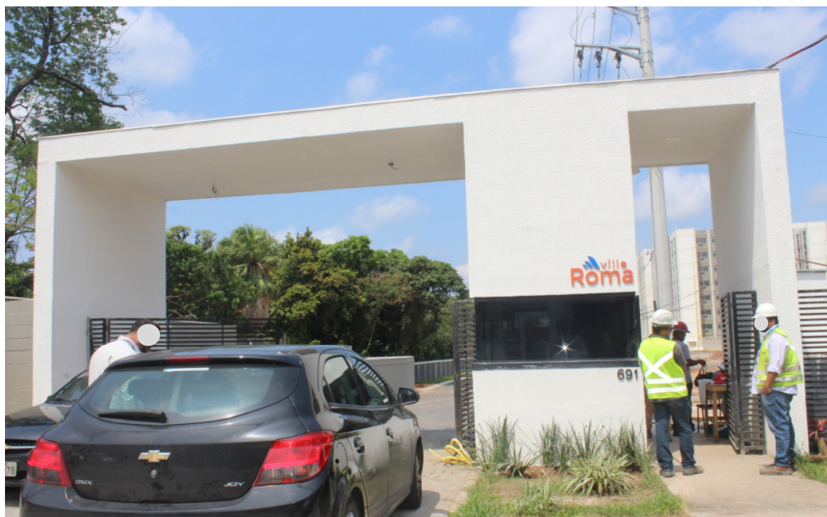
Foto 1: Fachada do condomínio
