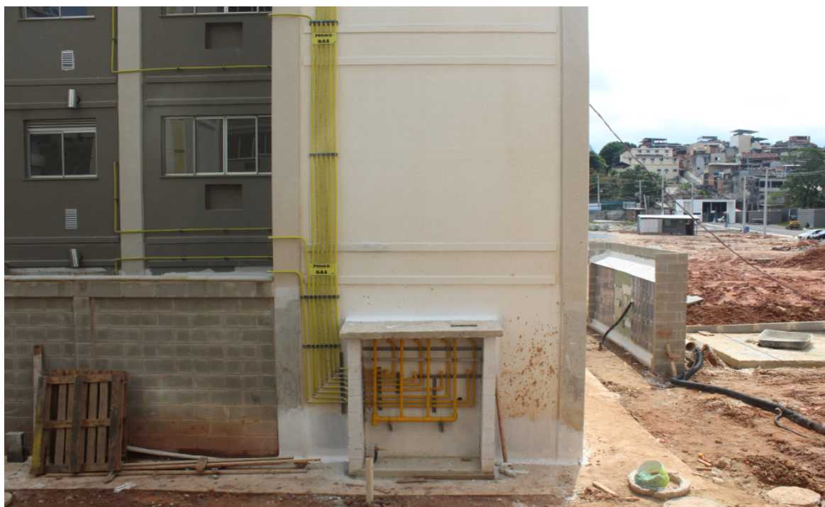
Foto 5: Instalação de ramal para rede interna
