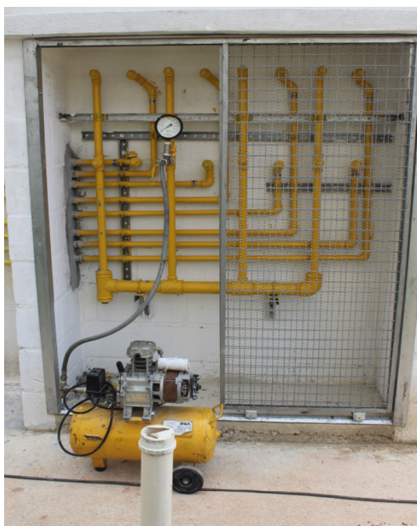
Foto 4: Teste de pressão interna
