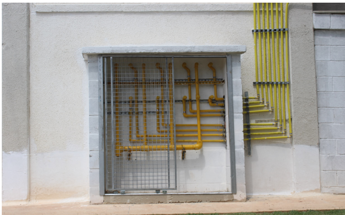
Foto 3: Instalação de ramal para rede interna
