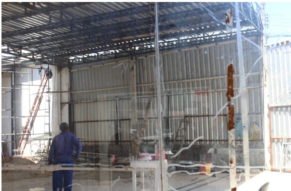
Foto 11: Futura instalação do setor de abastecimento de GNV
