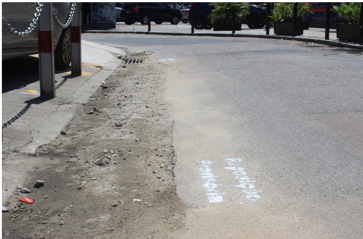
Foto 7: Recomposição provisória da via
