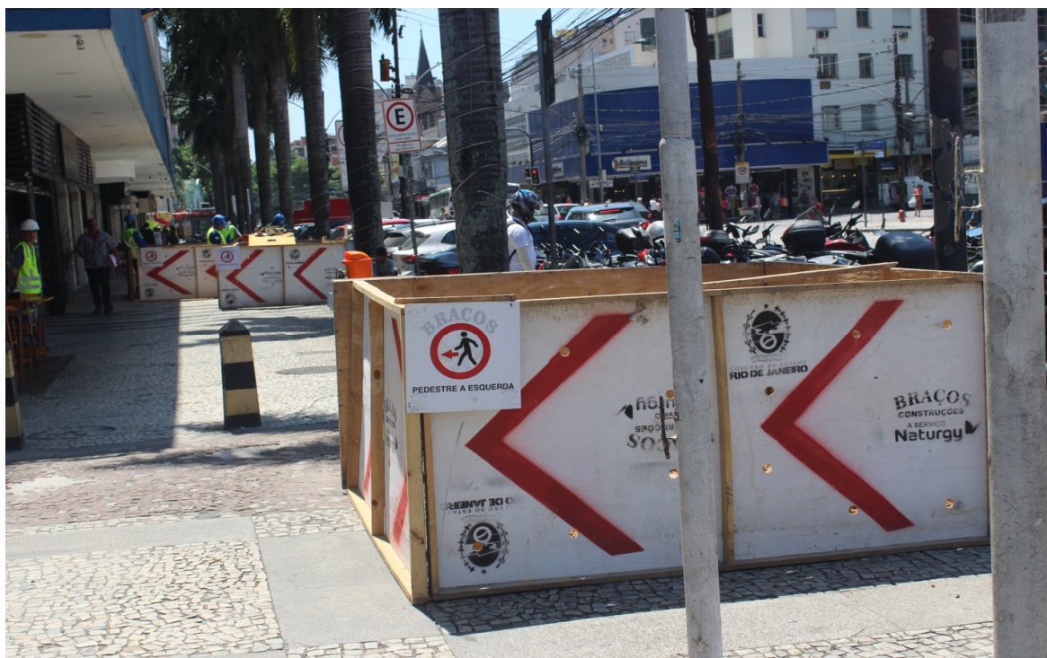
Foto 4: Isolamento de obra e sinalização de desvio
