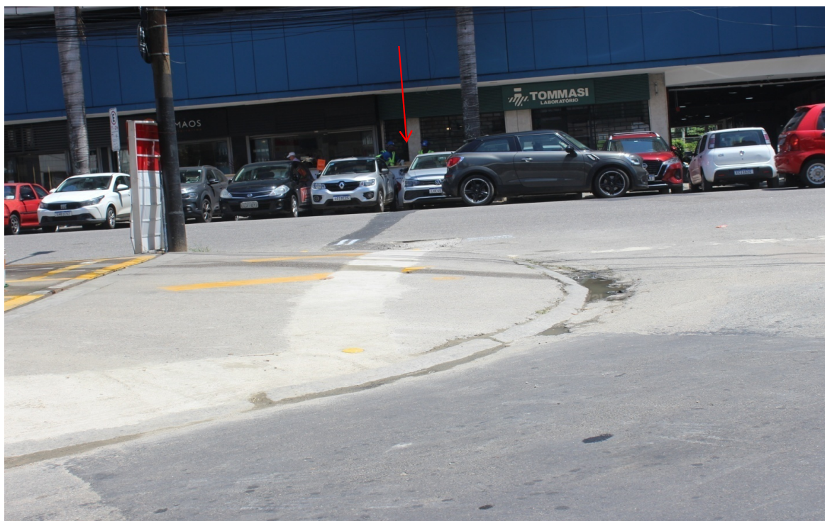
Foto 6: Recomposição e Ponto de interligação da rede a ser realizado
