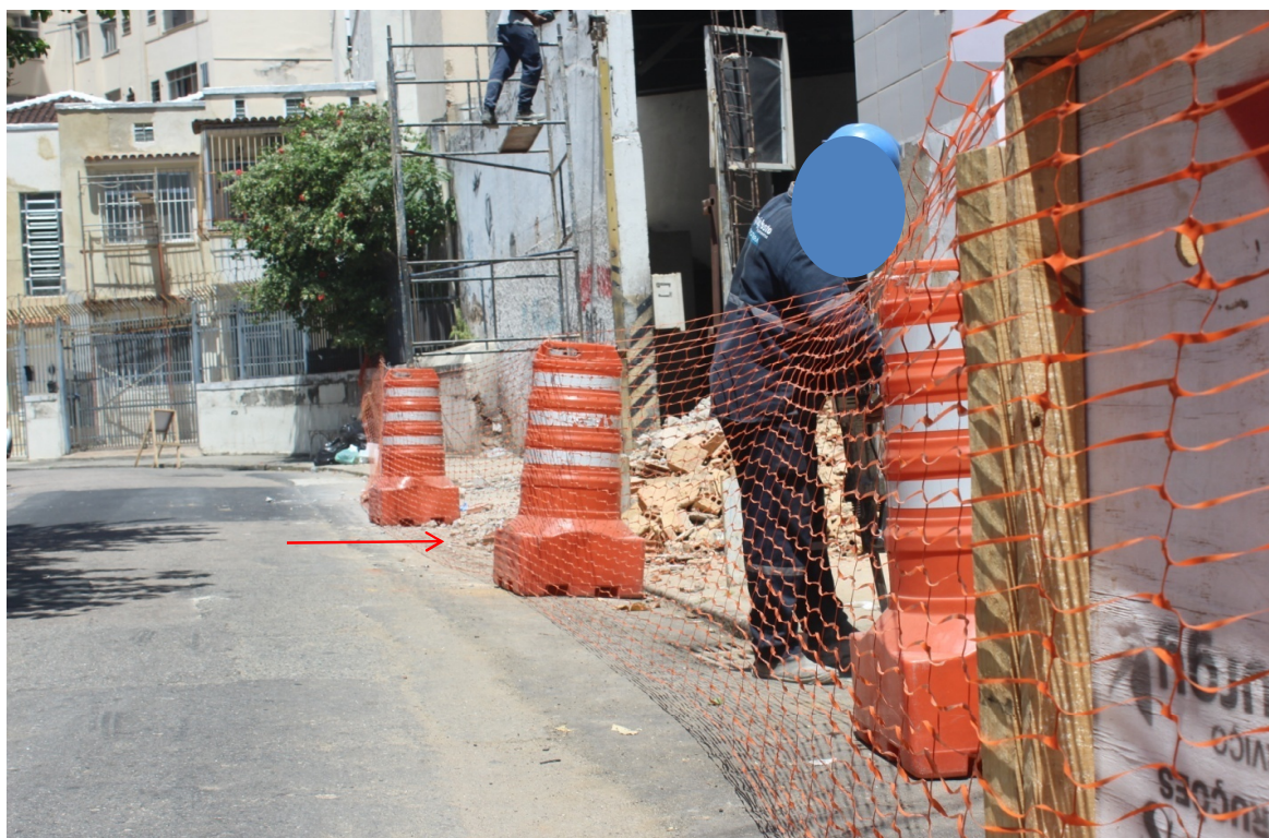
Foto 9: Ponto onde a rede está capeada e ramal a ser construído
