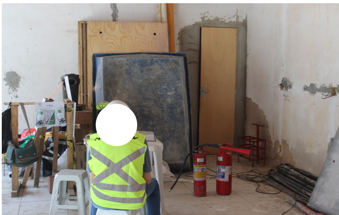
Foto 10: Local de vivência e extintores
