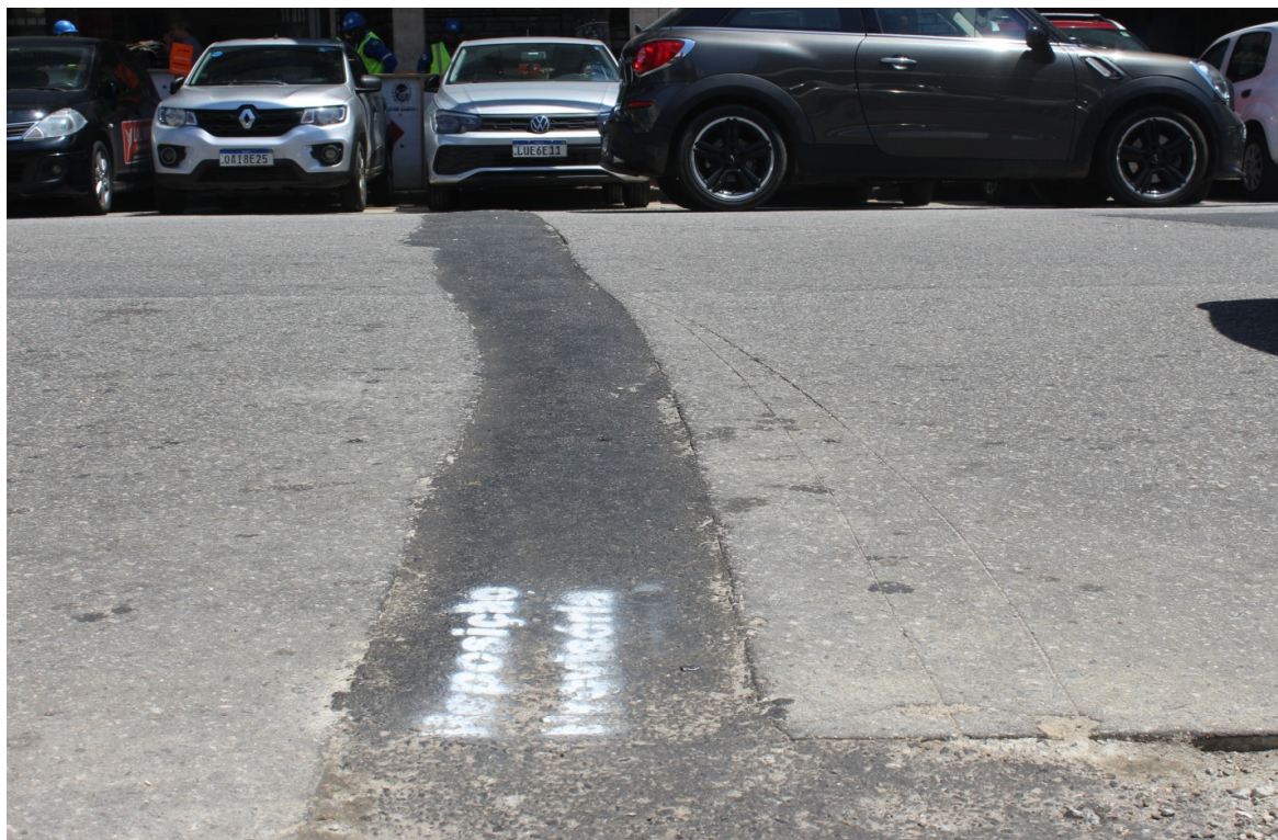
Foto 5: Recomposição provisória em travessia de rede
