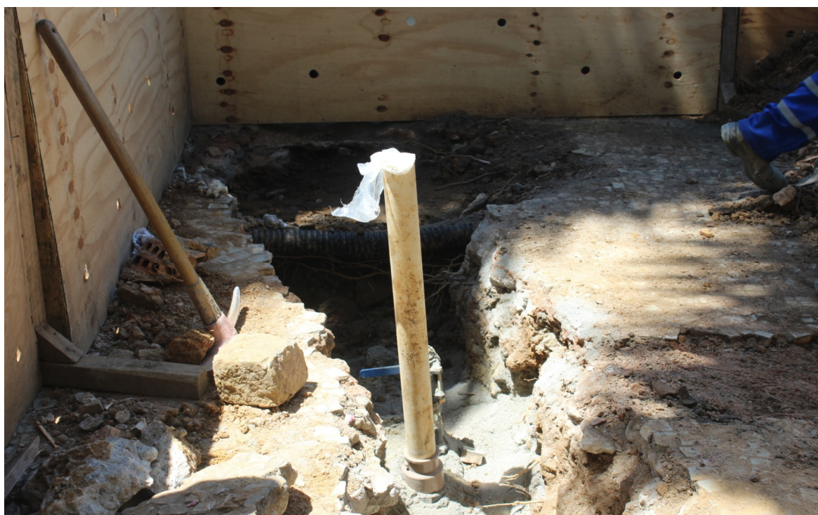
Foto 2: Ponto onde será realizada interligação
