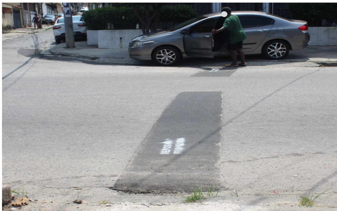
Foto 3: Recomposição provisória para interligação de rede
