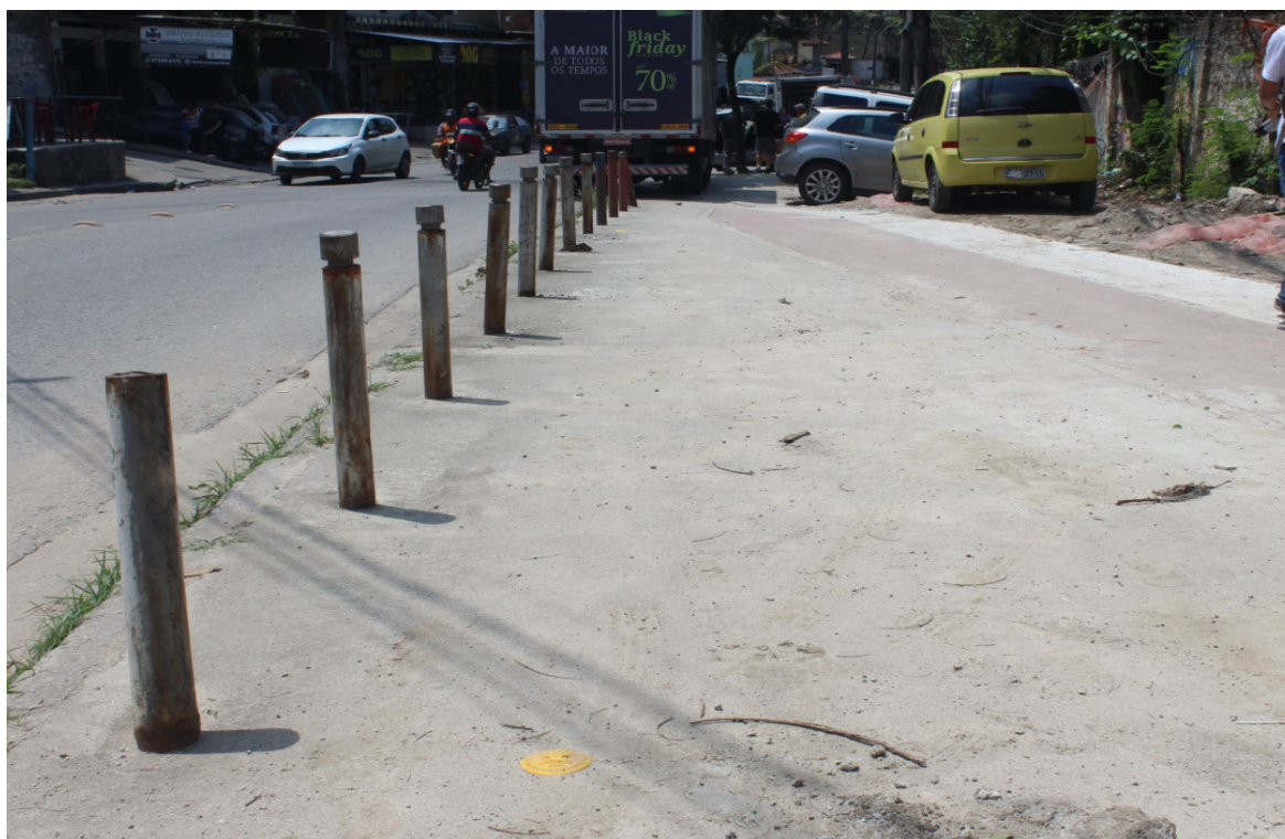
Foto 2: Marco planos indicando presença de rede
