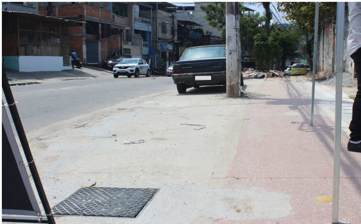
Foto 1: Início da obra
