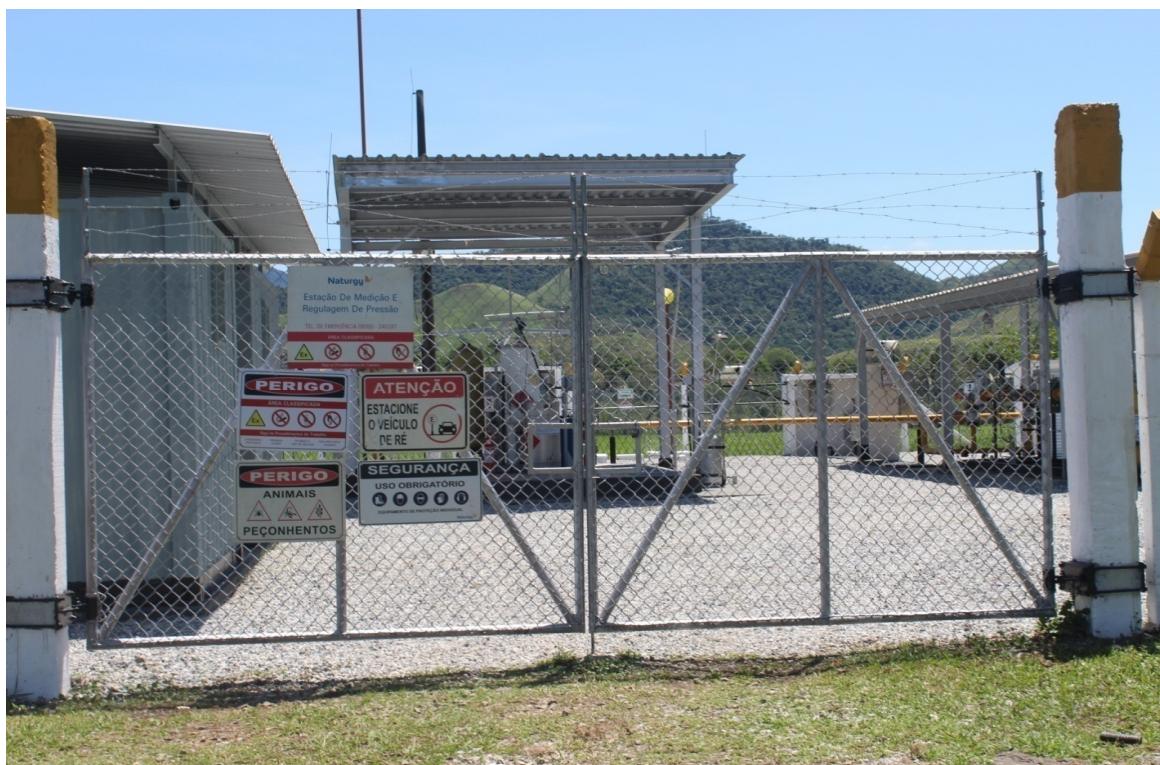
Foto 2: Entrada da estação e sinalização de segurança
