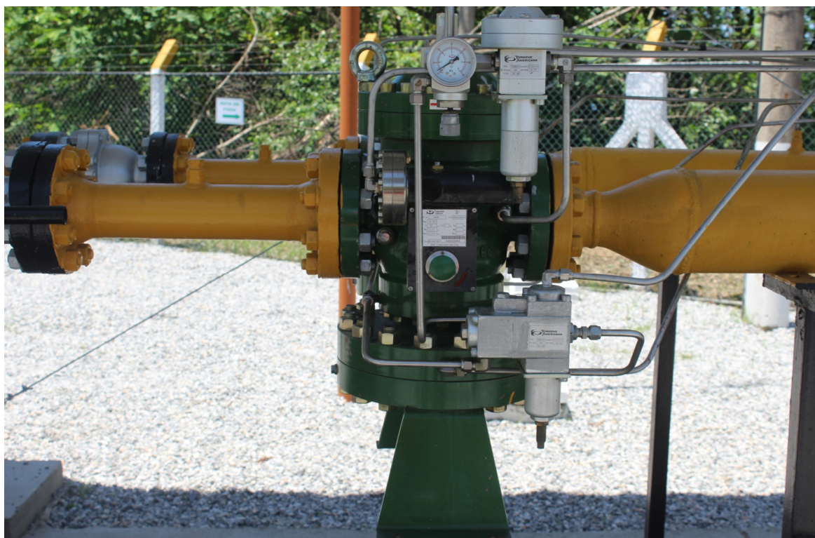
Foto 10: Regulador 3 em 1 (Ativo, monitor e bloqueio)
