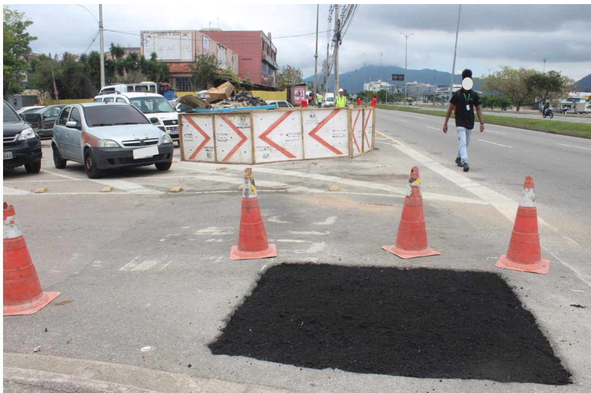
Foto 4: Recomposição e sinalização
