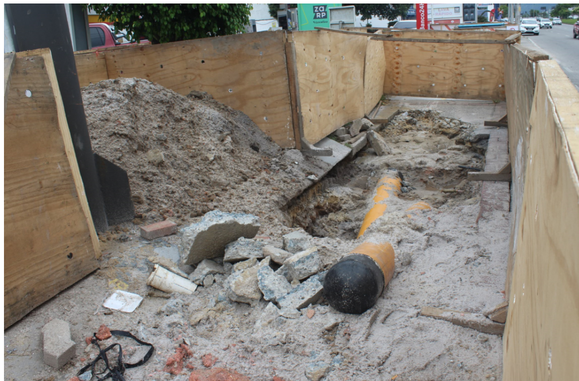
Foto 6: Tubulações a serem interligadas por luva
