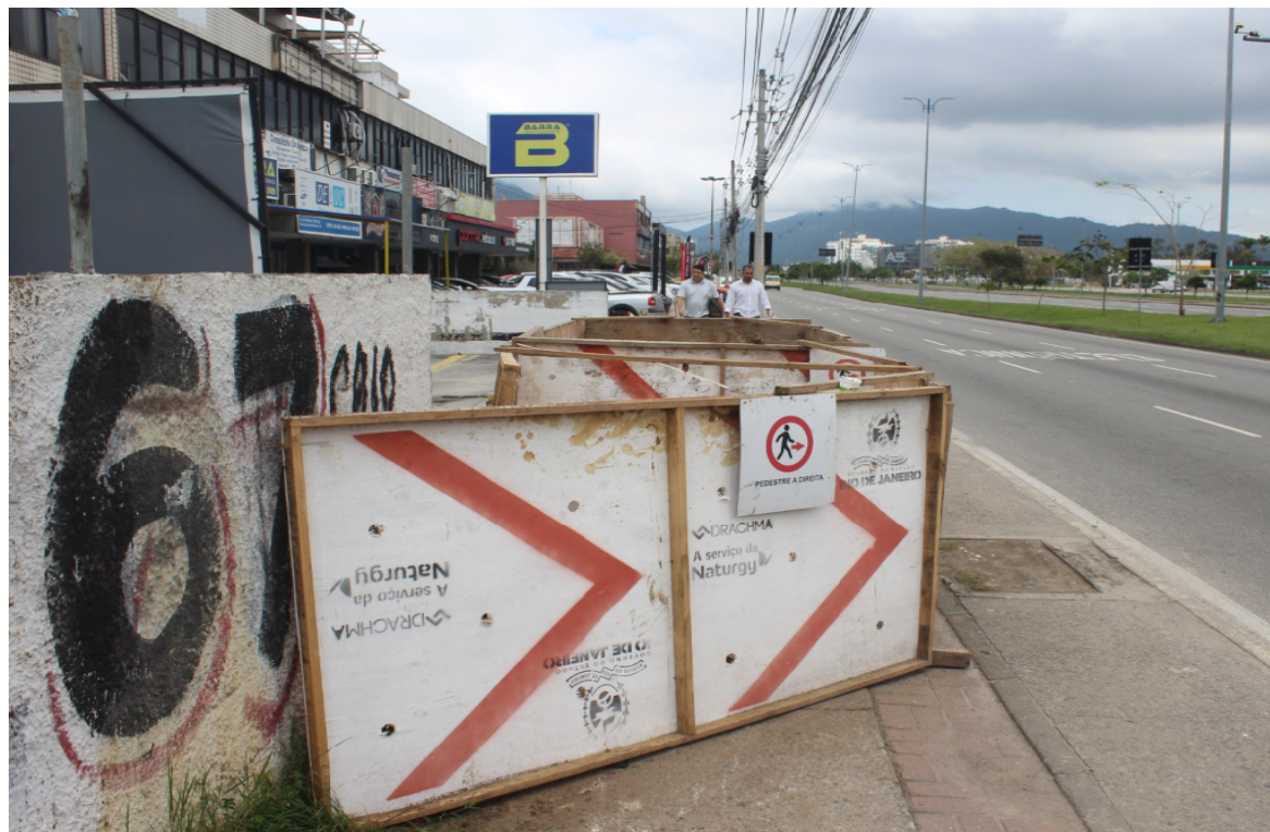
Foto 2: Isolamento e sinalização
