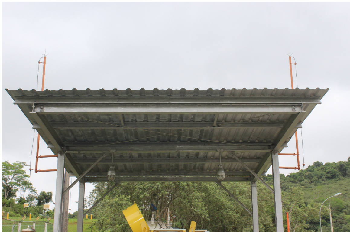
Foto 14: Cobertura da estação de odorização
