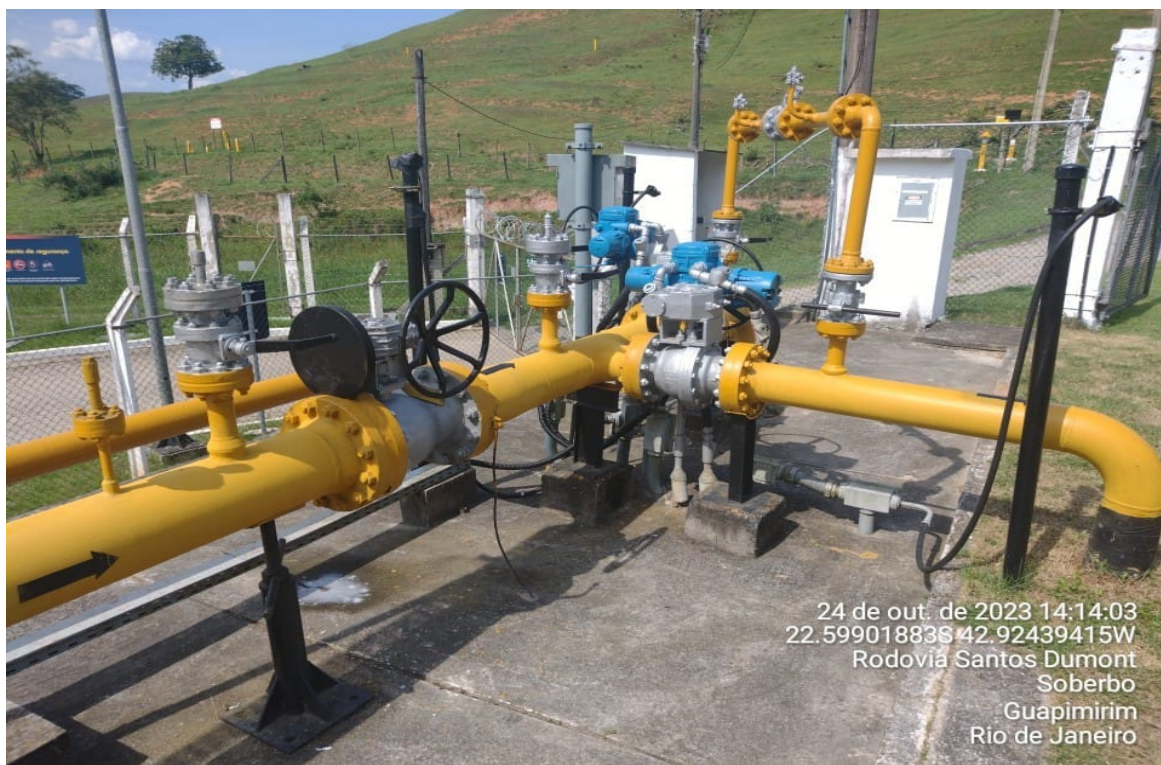
Foto 24: Melhoria realizada na conservação da tubulação
