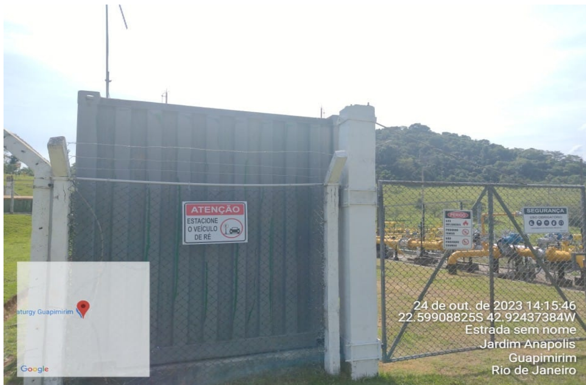
Foto 20: Instalação de placa de sinalização de segurança
