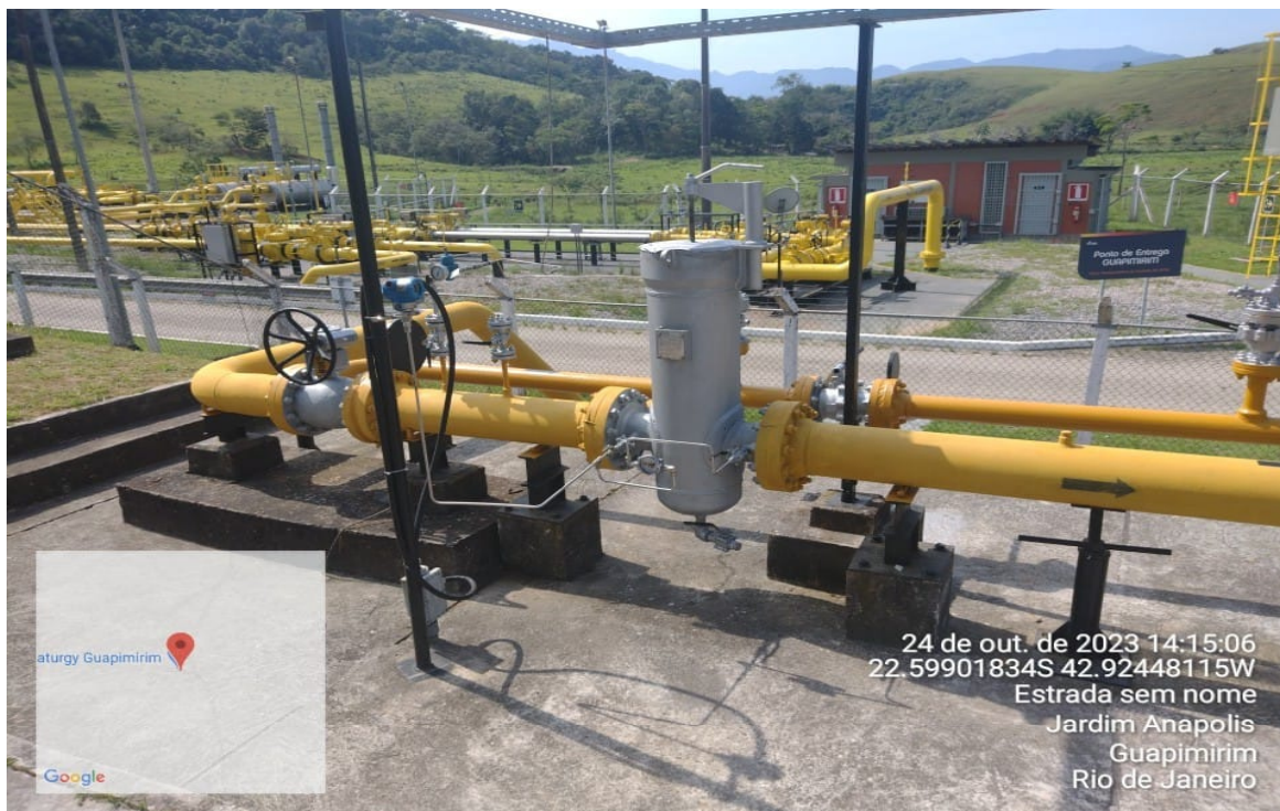
Foto 21: Melhoria realizada na conservação da tubulação
