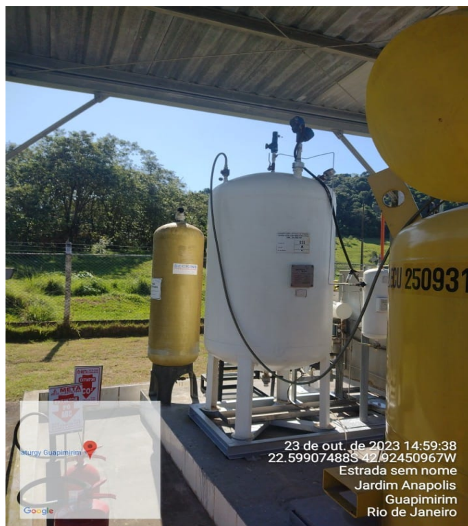
Foto 22: Limpeza realizada em tanque de armazenamento
