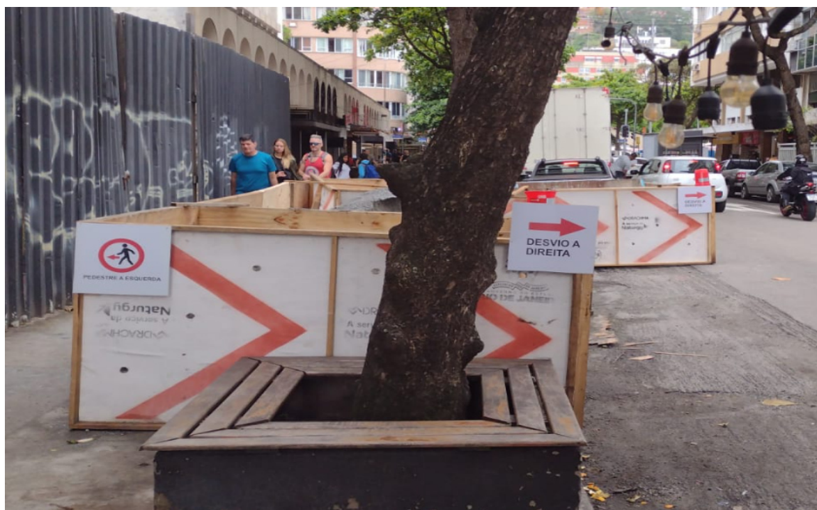
Foto 6: Sinalização de obras (depois)
