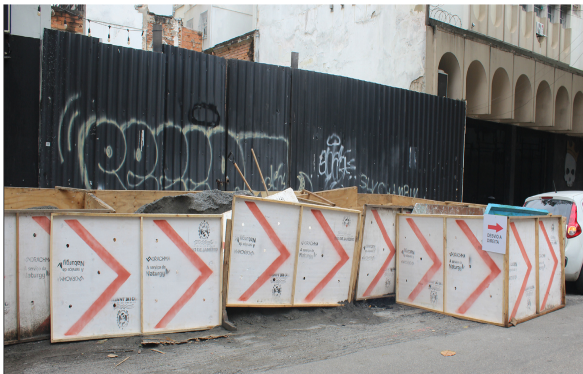
Foto 5: Sinalização de obra (antes)
