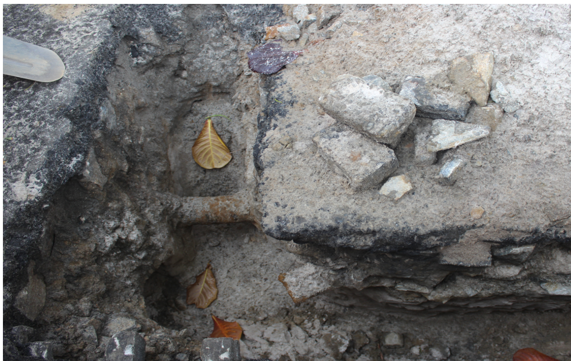
Foto 2: Sondagem de rede
