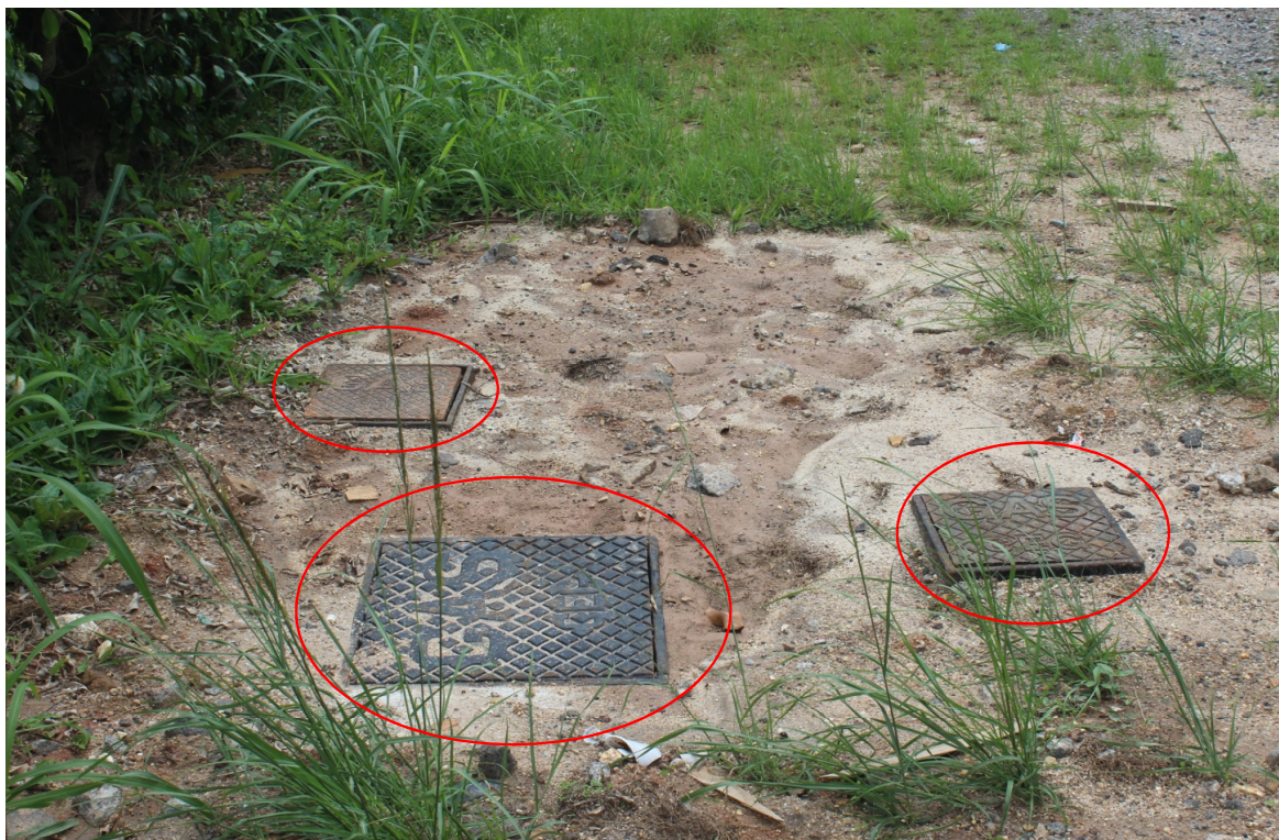
Foto 1: Válvula de segurança e vent
