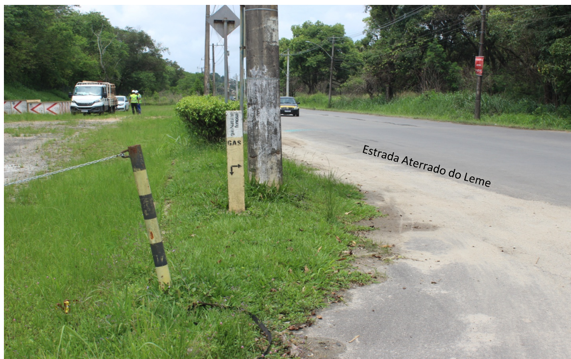
Foto 6: Local da obra (marco sinalizador de presença de gasoduto)
