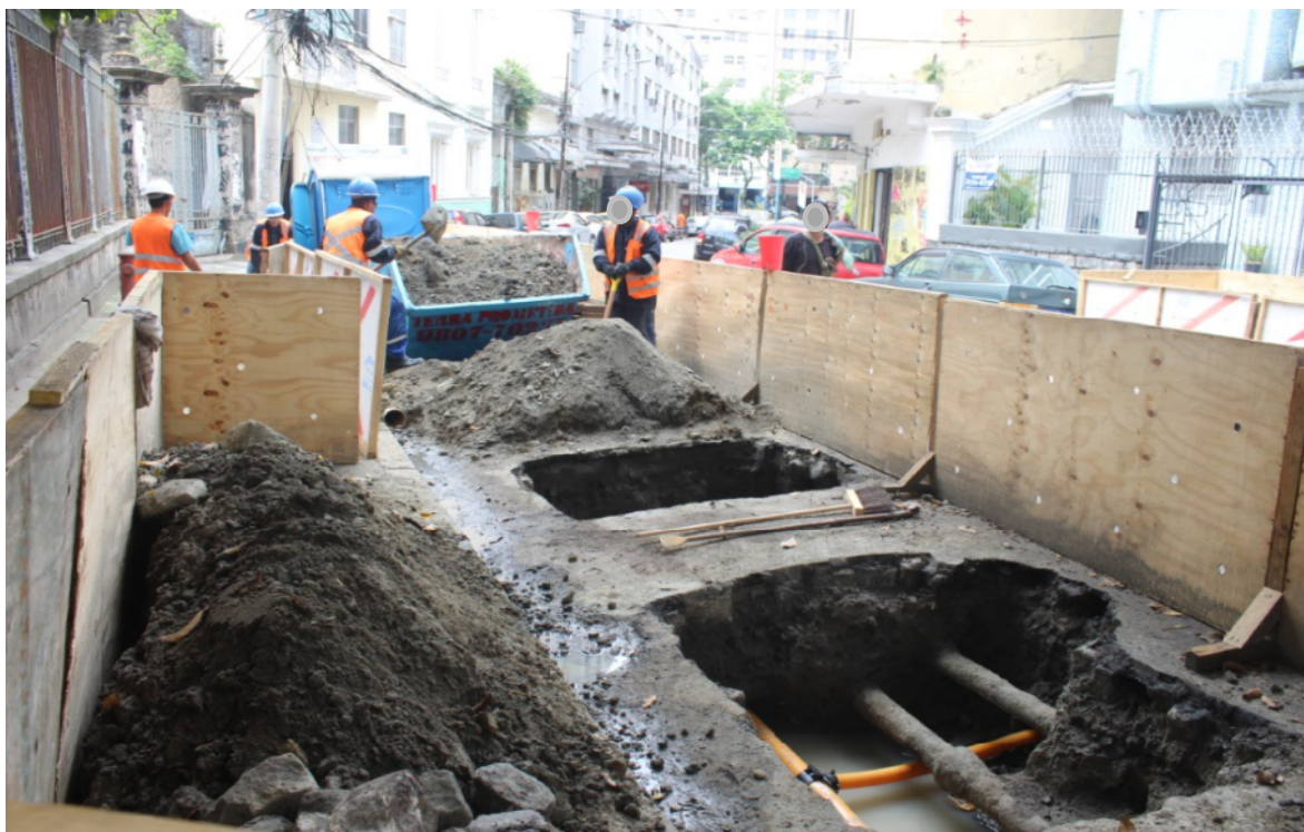
Foto 2: Renovação de rede
