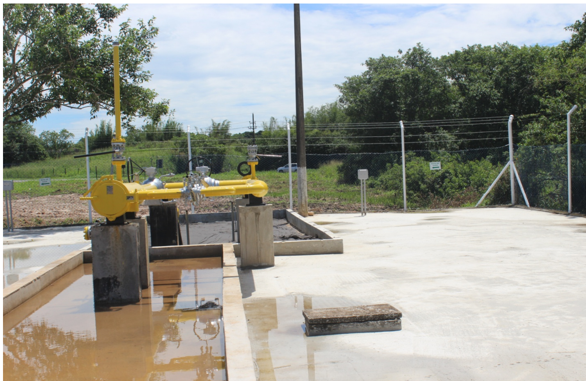
Foto 16: Canhão lançador de PIG de 8"
