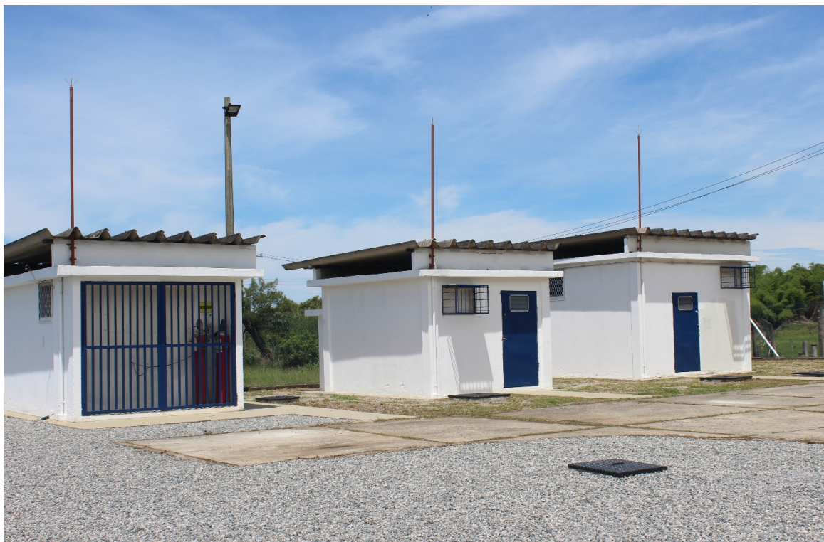
Foto 12: Sala de Cromatografia, Controle e Elétrica
