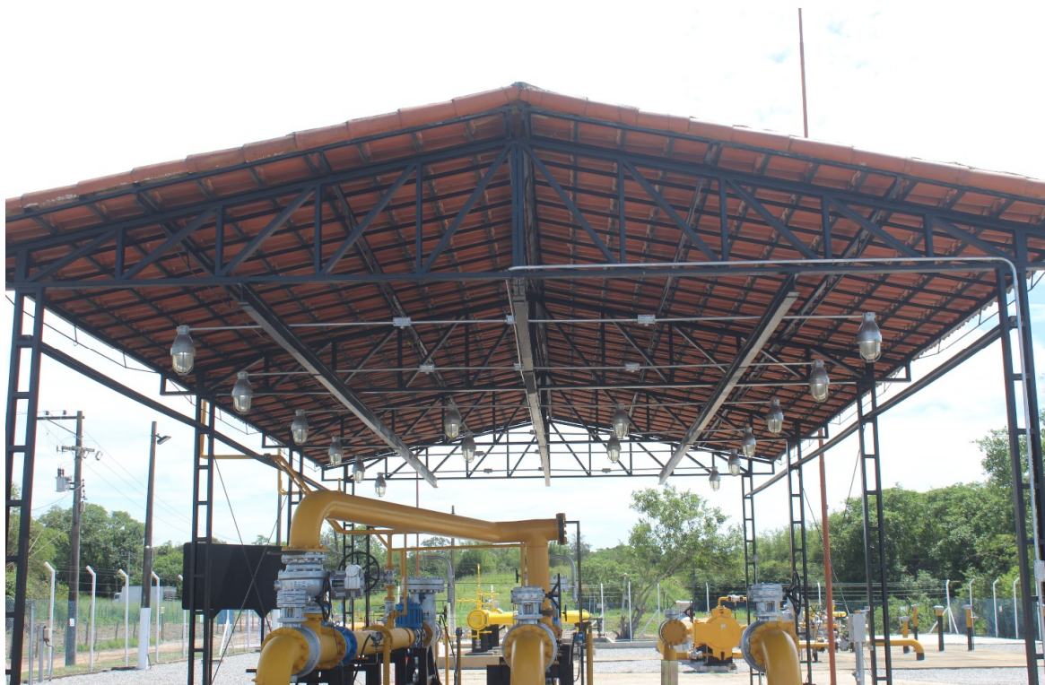
Foto 10: Cobertura da estação
