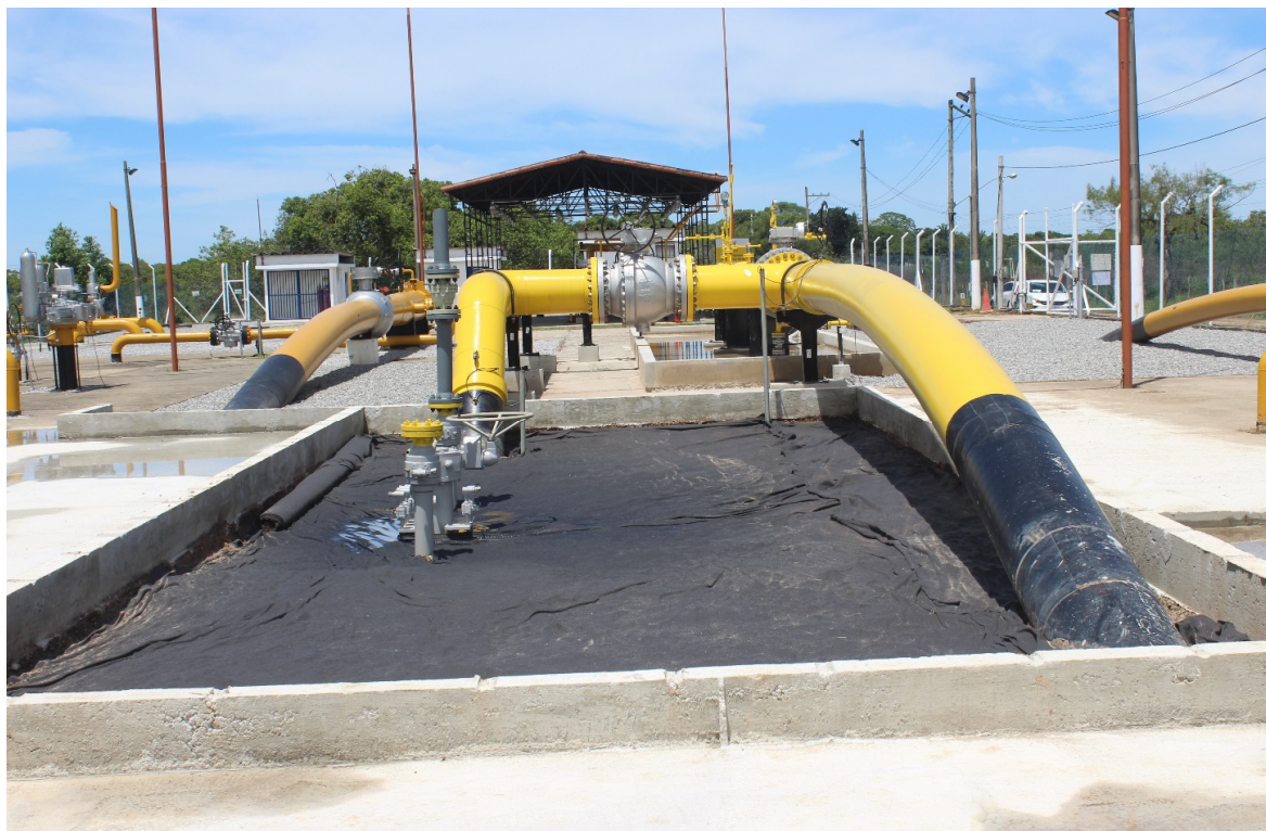
Foto 18: Canhão receptor de PIG
