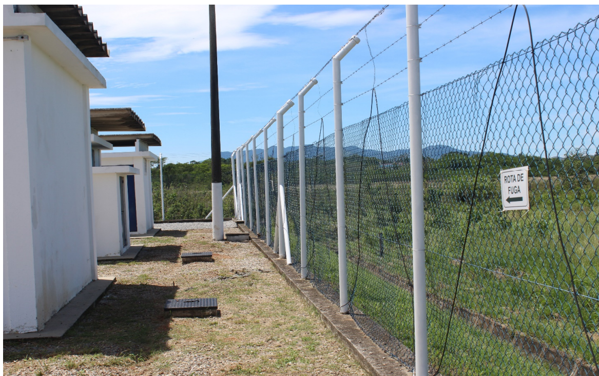
Foto 17: Cerca e placas de rota de fuga
