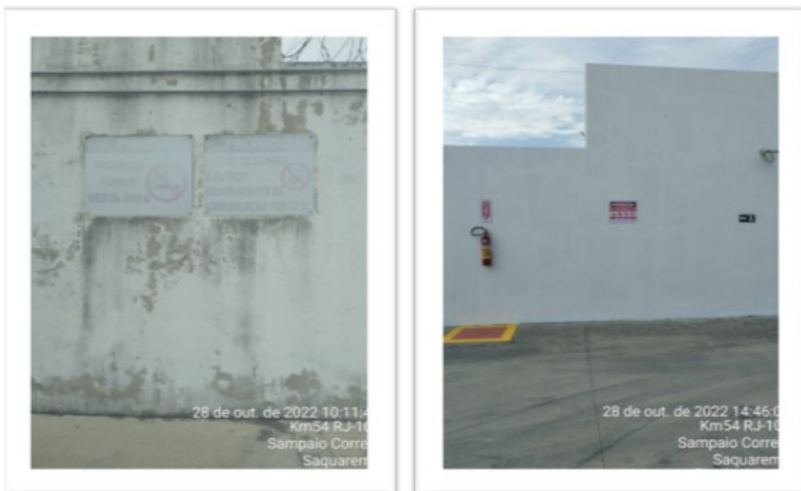
Foto 10: Sinalização de segurança (antes e depois)
