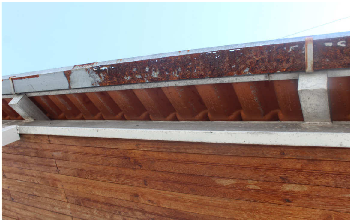
Foto 11: Calha deteriorada
