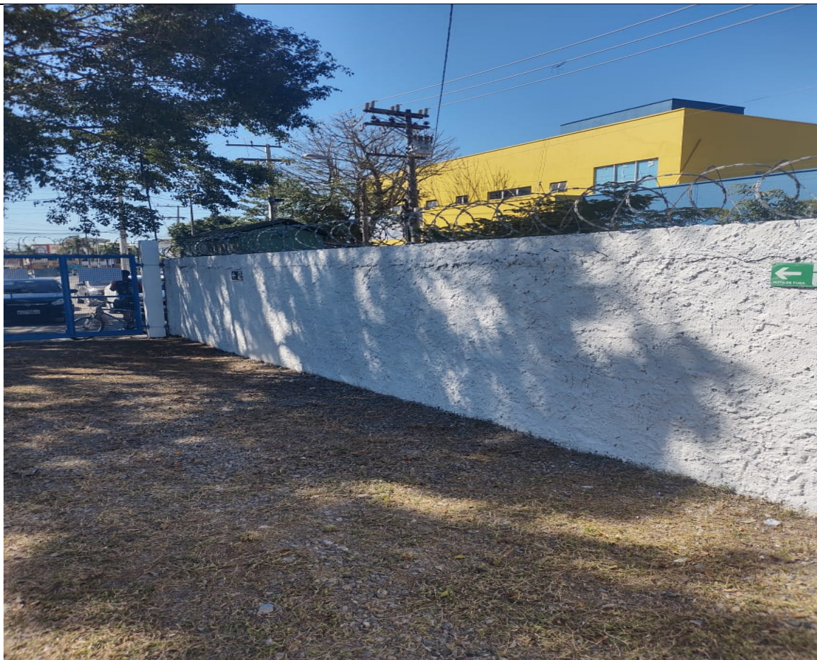
Foto 5: Muro lateral com placas de rota de fuga.
