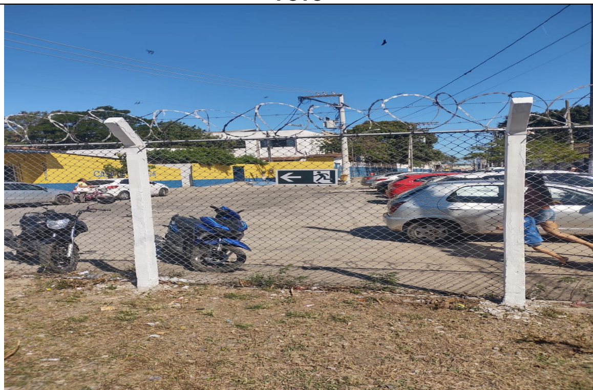
Foto 4: Cerca de fundo com placa de rota de fuga.
