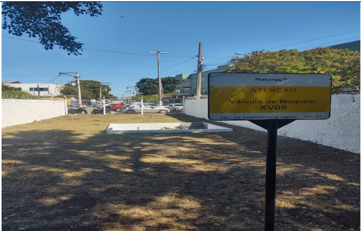
Foto 1: Vista da estação.
