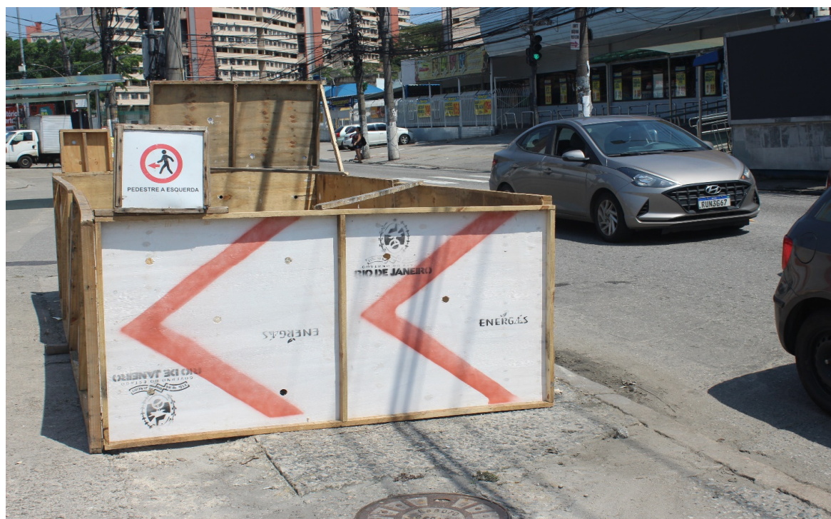
Foto 2: Isolamento e placa de desvio de pedestre
