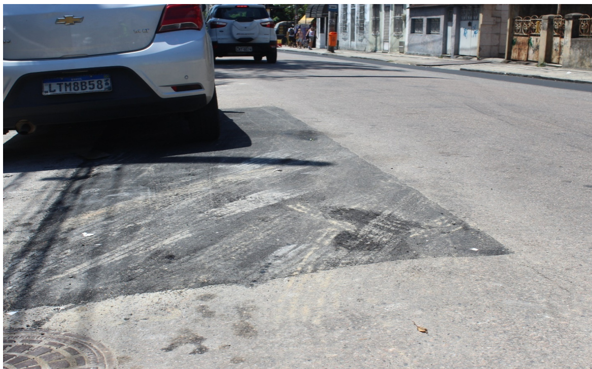
Foto 8: Recomposição de abertura na via (lado par)
