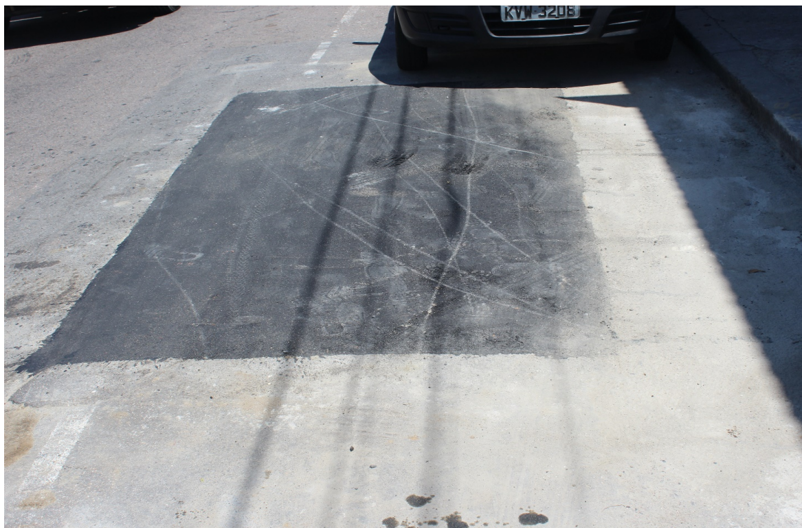
Foto 9: Recomposição de abertura na via (lado par)
