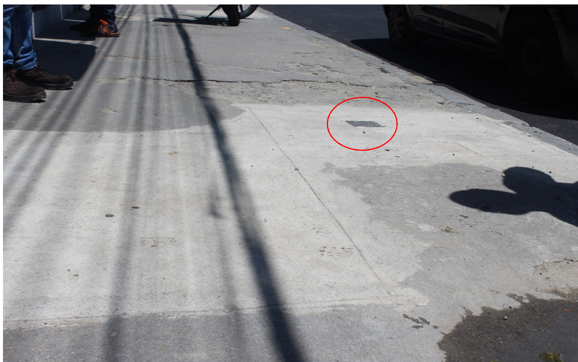
Foto 4: Recomposição do passeio (válvula de ramal)
