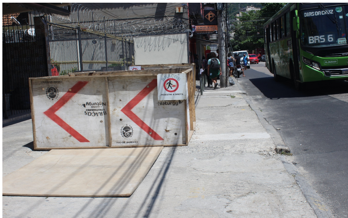
Foto 6: Isolamento e sinalização de desvio
