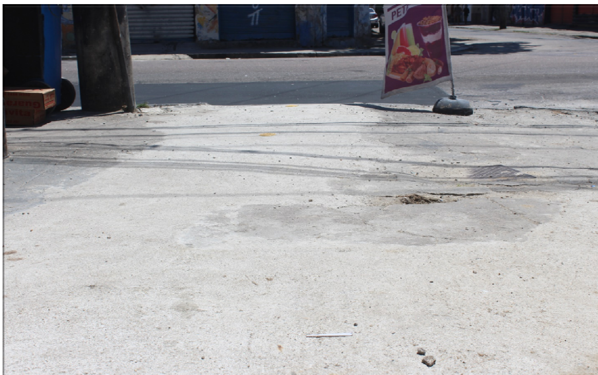
Foto 2: Ponto de início da obra (lado ímpar)
